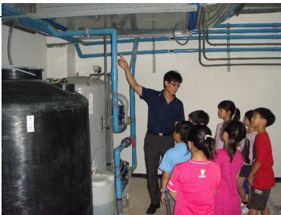
說明：設置於地下室中水及雨水過濾設備系統
