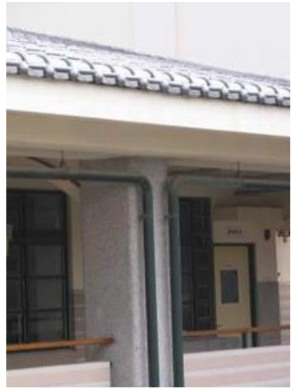
說明：雨水回收管(綠水管)
