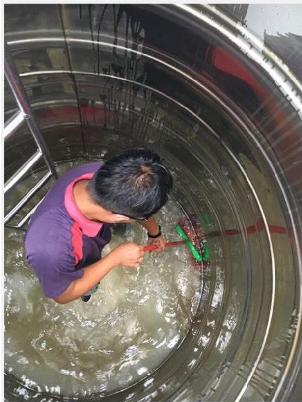
3.水塔內部清洗中
