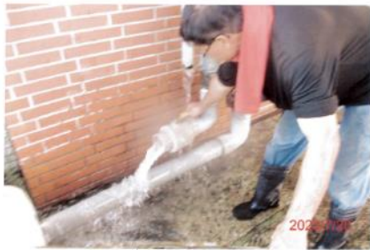
管路檢查作業中
