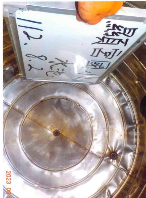
蓄水池清洗後
