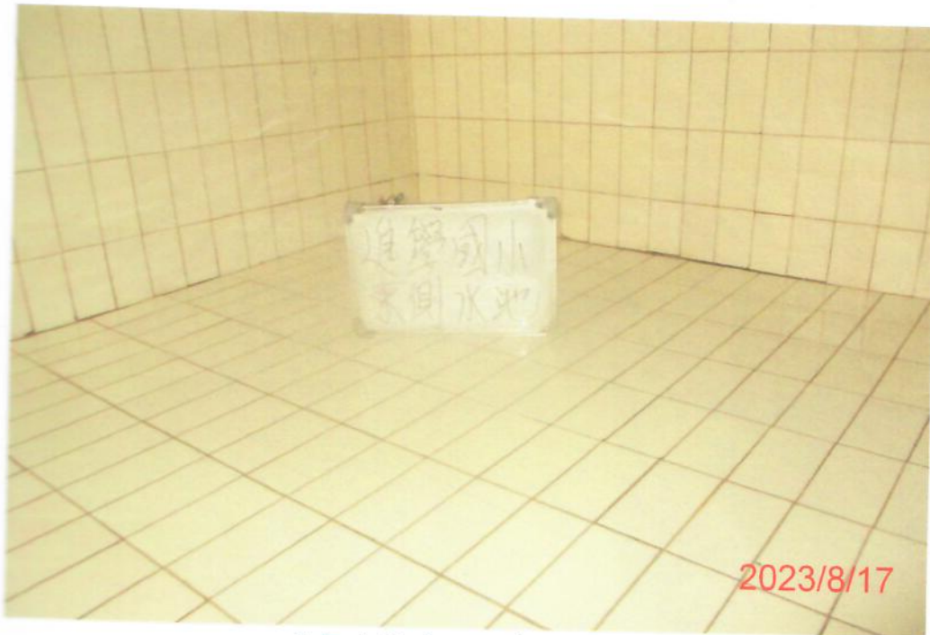
(東側)水池清洗後
