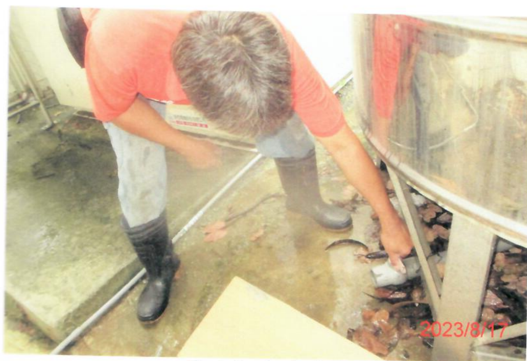
管路檢查作業中
