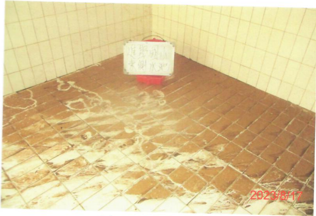
(東側)水池清洗前
