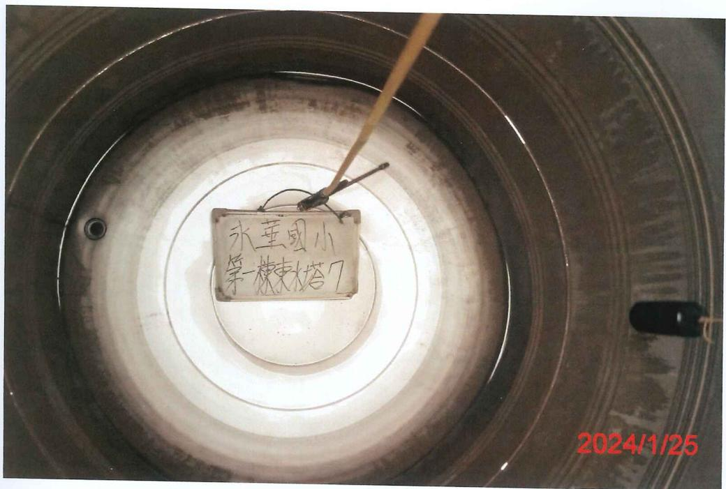
(第一棟東側-7)水塔清洗後
