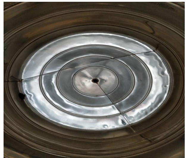
說明：水塔清洗後
