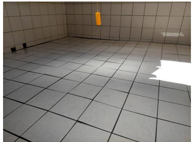
說明：水塔清洗後
