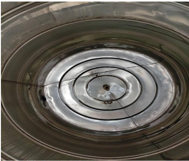
說明：水塔清洗前
