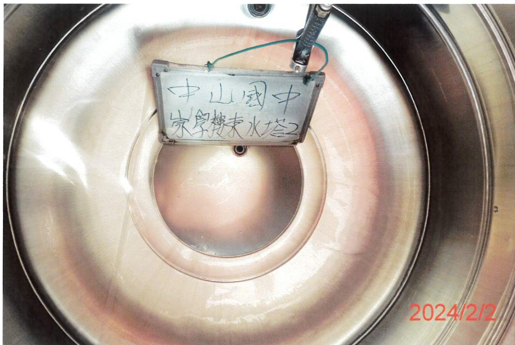
(崇學樓東側-2)水塔清洗後
