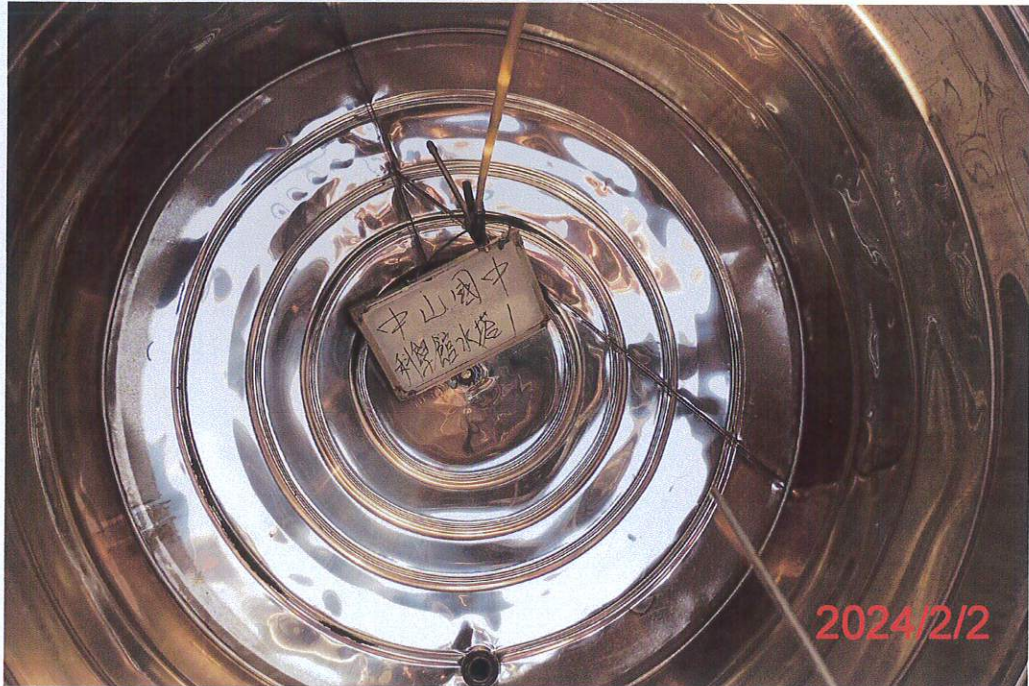
(科學館-1)水塔清洗前
