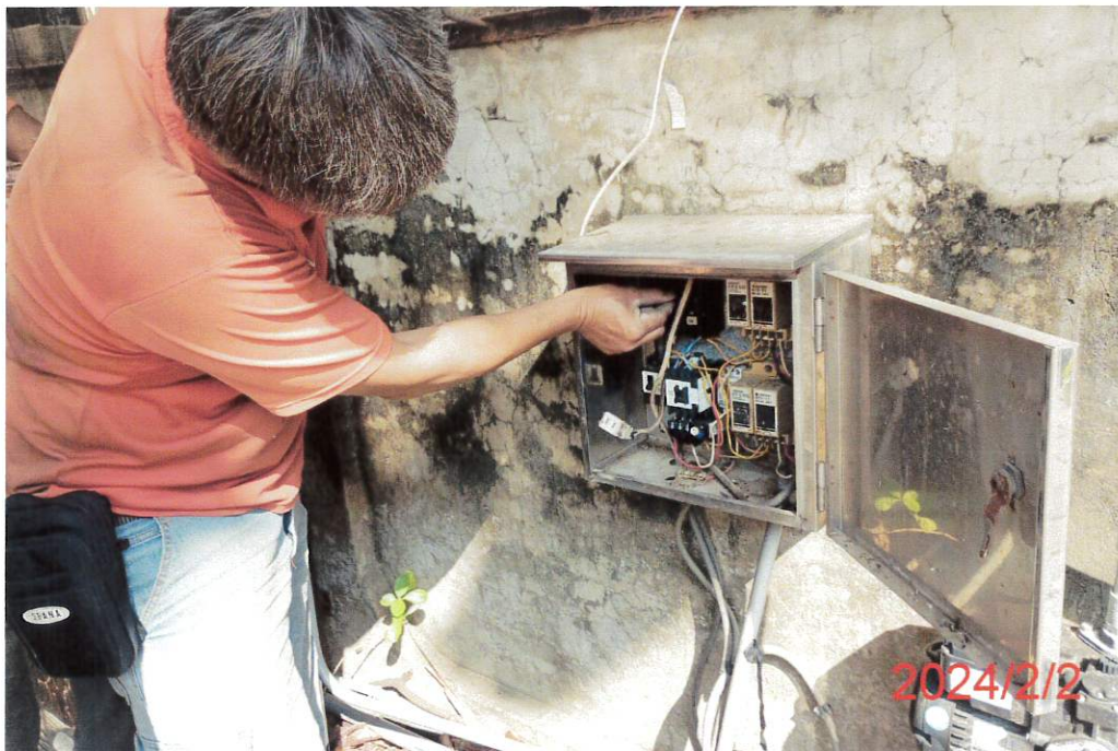
電控檢查中作業
