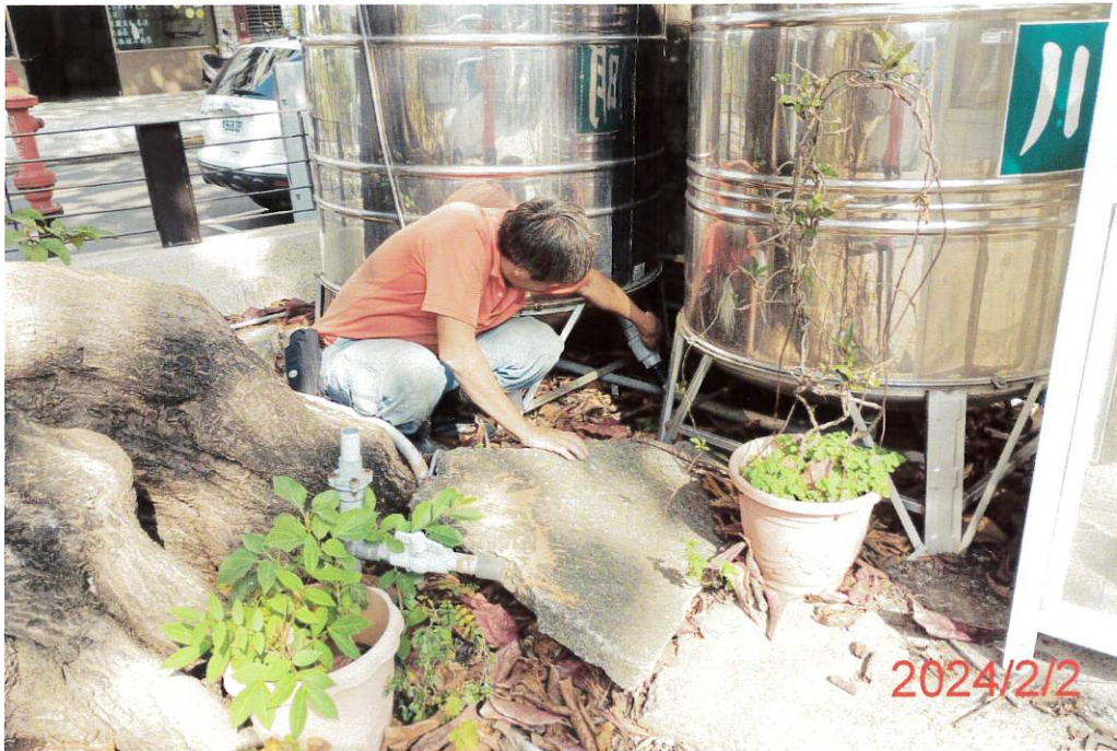
管路檢查作業中
