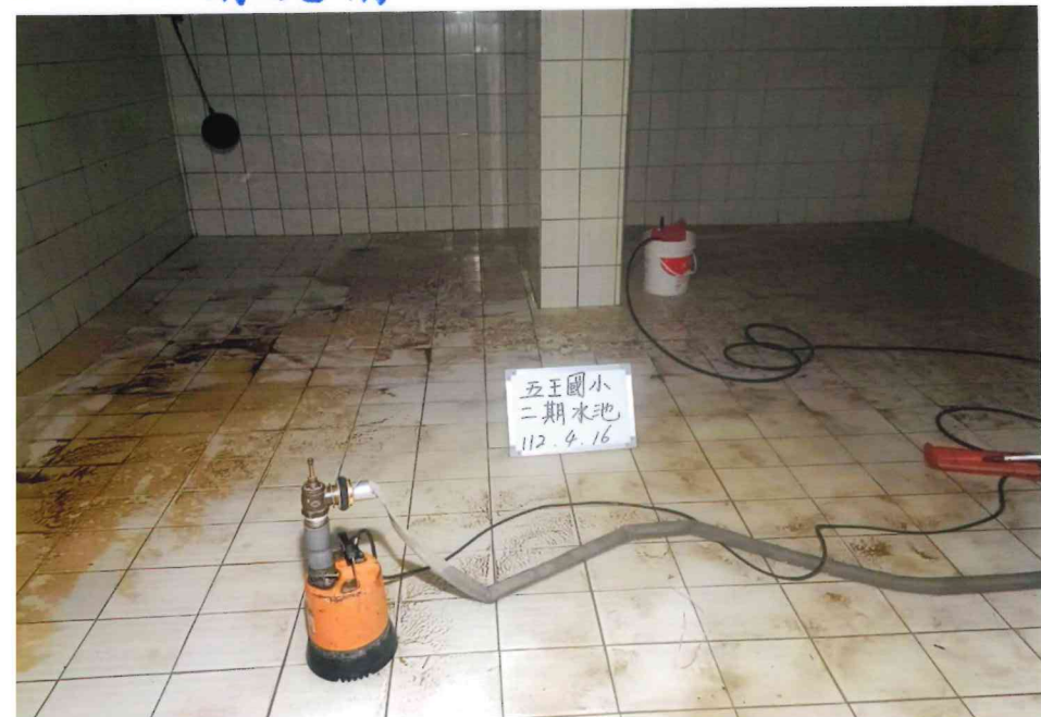
蓄水池清洗前
