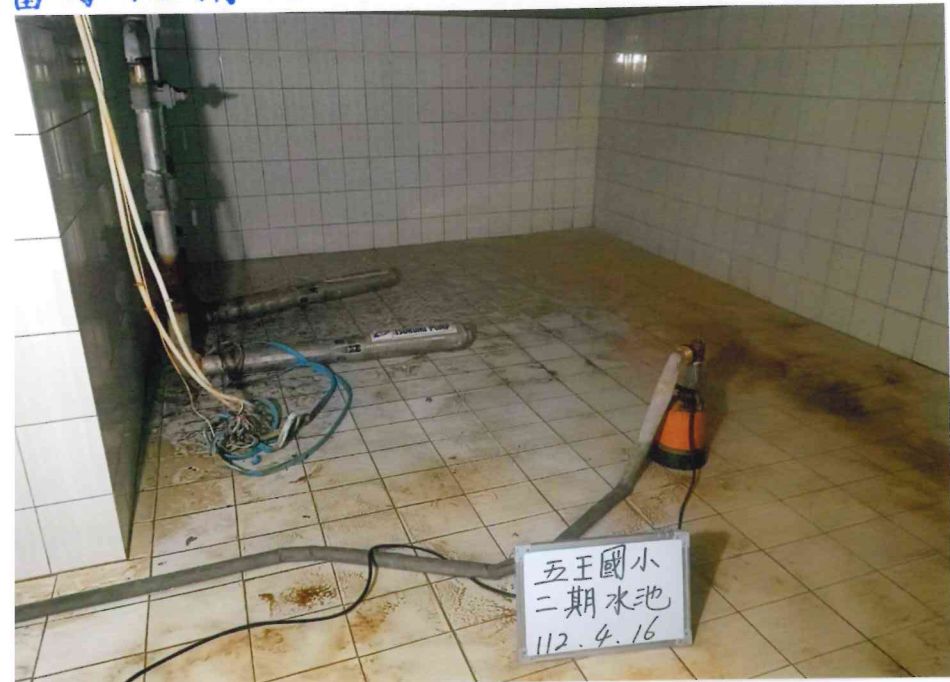
蓄水池清洗前
