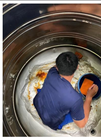
教是水塔定期清洗
