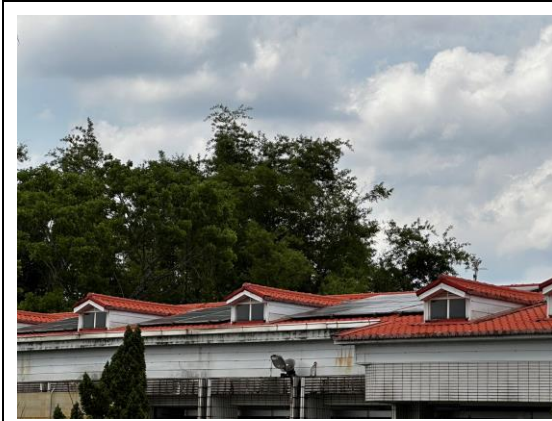
學校屋頂裝設太陽能發電面板
