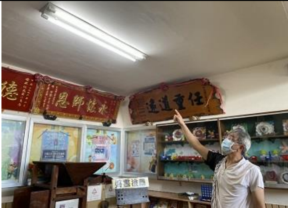
說明：樓梯間迴廊燈具檢查
