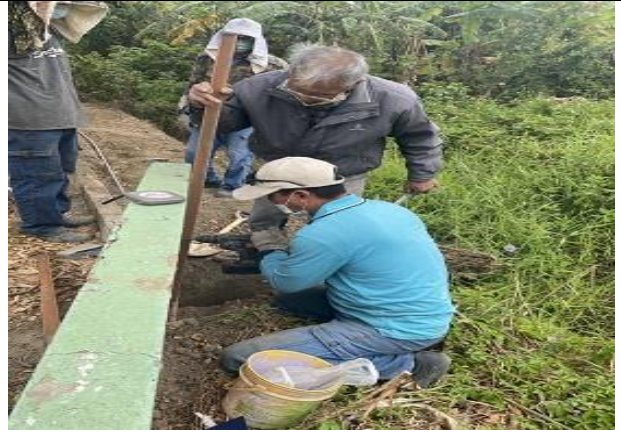
說明：校園東側圍牆修繕
