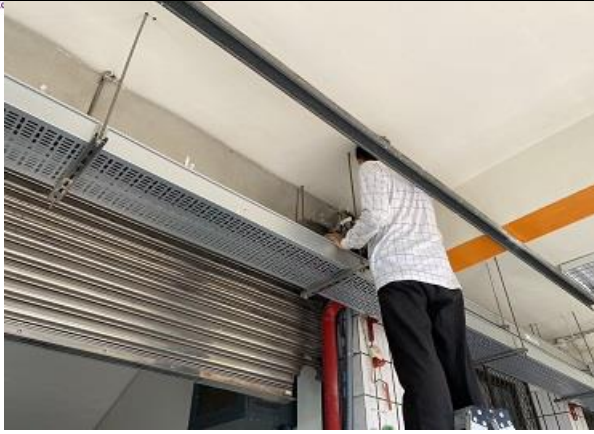
說明：教學大樓鐵捲門檢修
