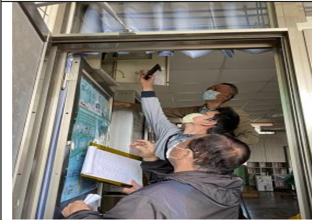
說明：校園電力設備檢查(1)
