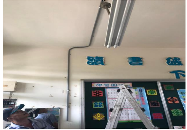
說明：若測出照度不足，總務處進行照度修繕
