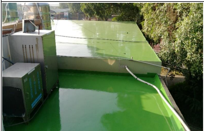
RO 系統廢水
