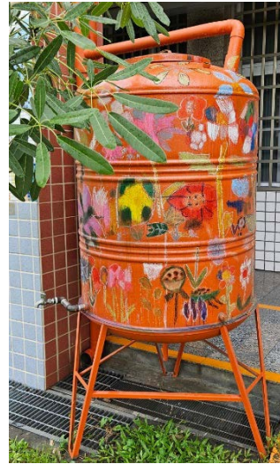
雨水回收(水撲滿)(衛生永續)
