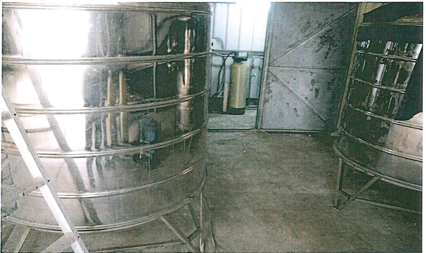
說明：外觀清洗後
