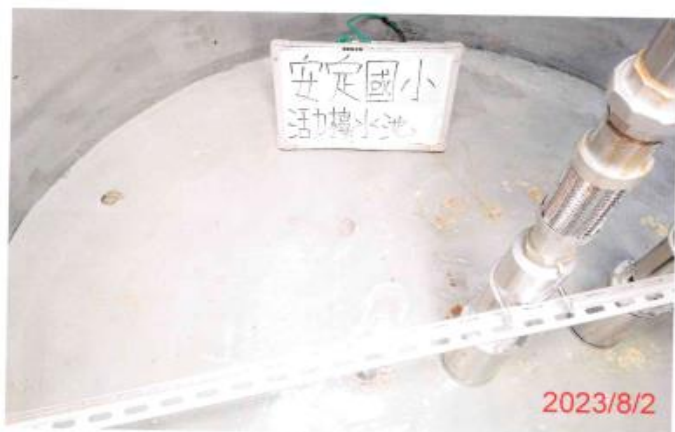
(活力樓)水池清洗後
