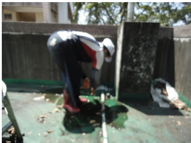
說明：水塔清洗
