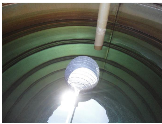
說明：水塔清洗
