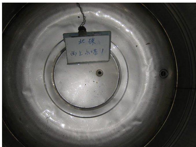
水塔洗淨後照片
