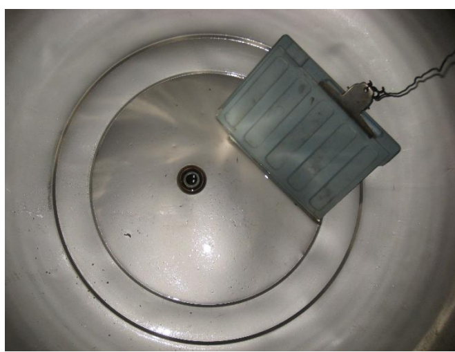
水塔洗淨後照片
