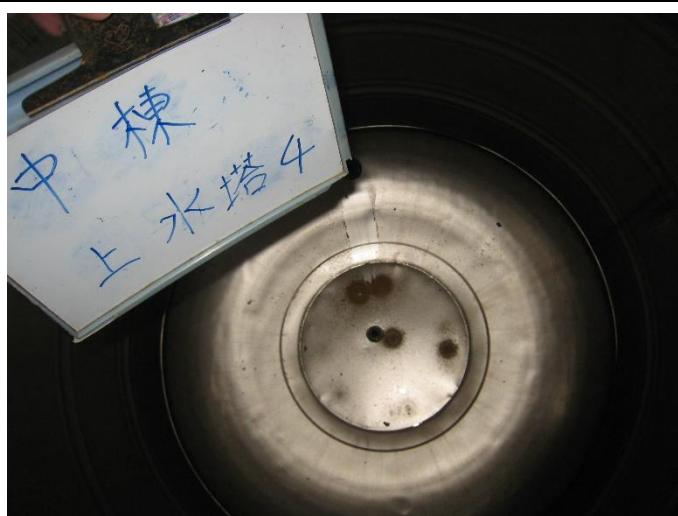
水塔洗淨後照片
