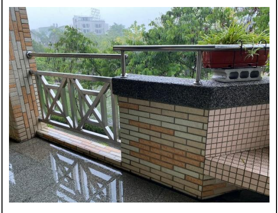
加高欄杆高度
