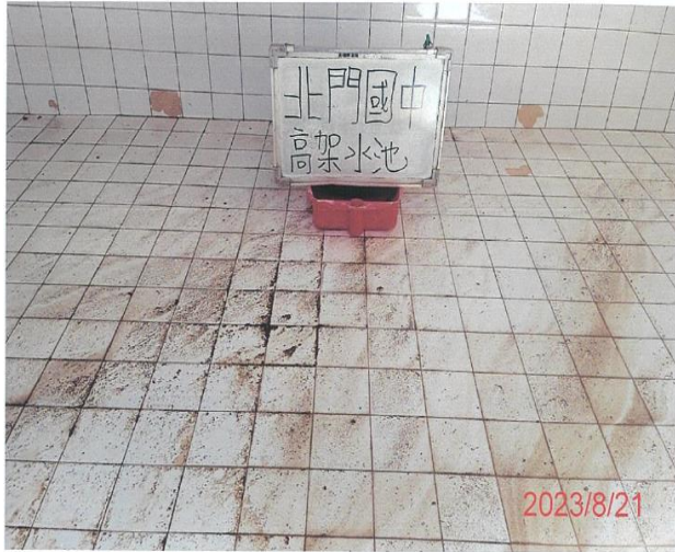
說明：高架水塔清洗前
