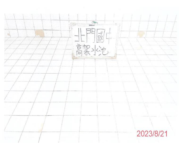
說明：高架水塔清洗後
