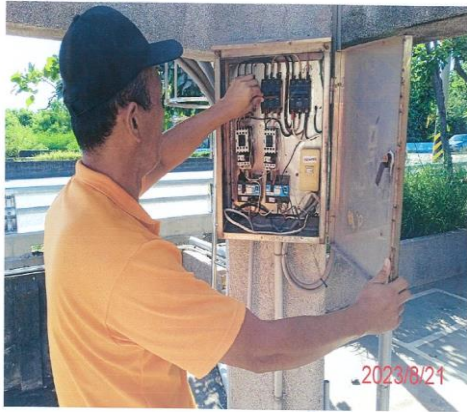
說明：電控中檢查作業
