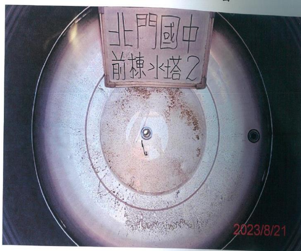
說明：水塔清洗前
