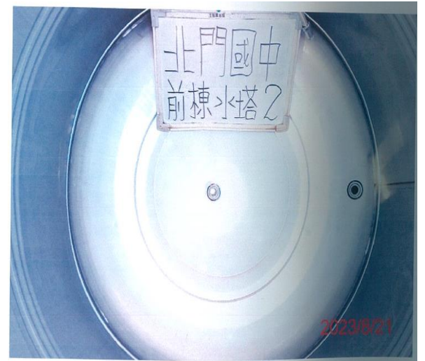
說明：水塔清洗後
