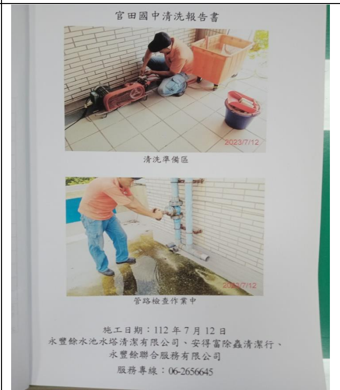
說明：水塔清洗前準備
