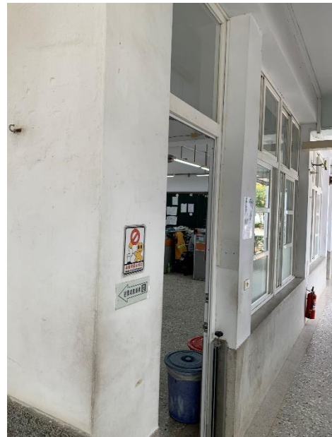
辦公處室入口處張貼禁菸標語
