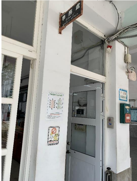
辦公處室入口處張貼禁菸標語
