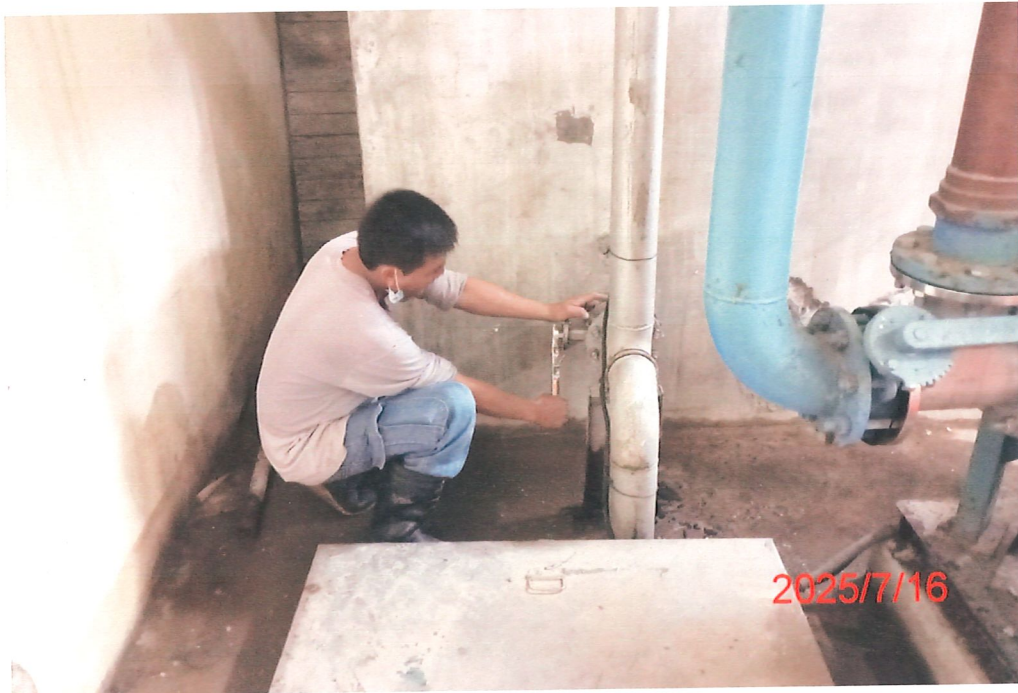
管路檢查作業中
