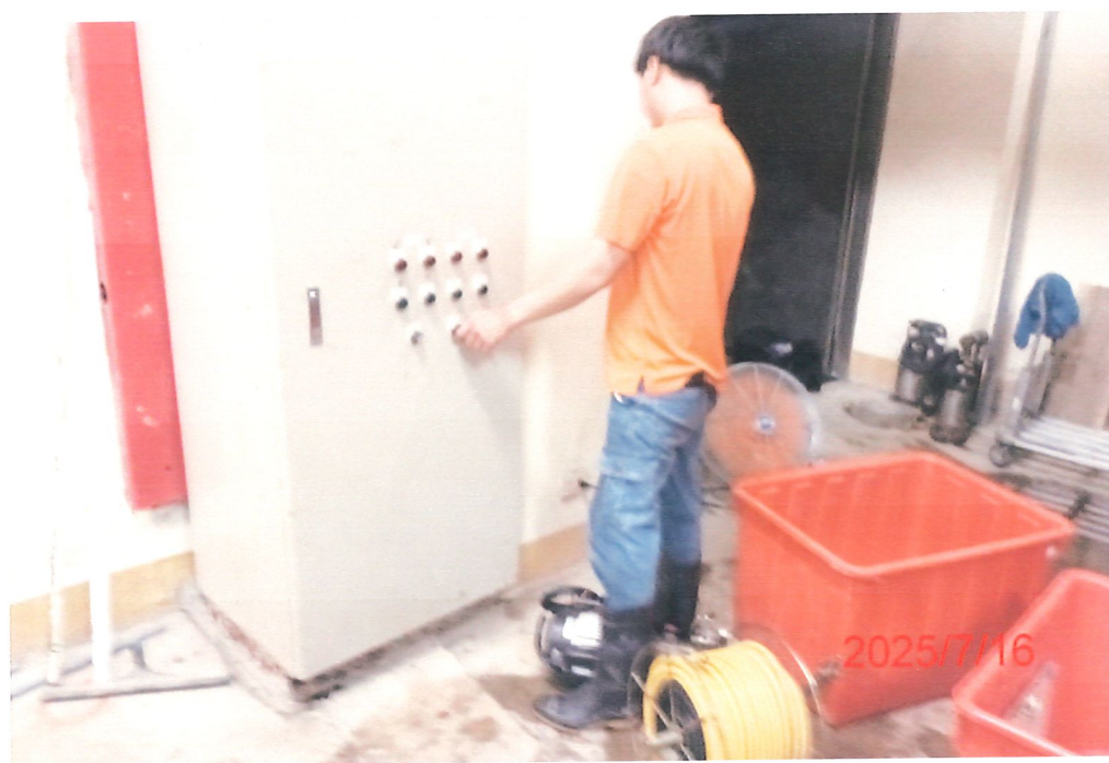
作業後電控檢查
