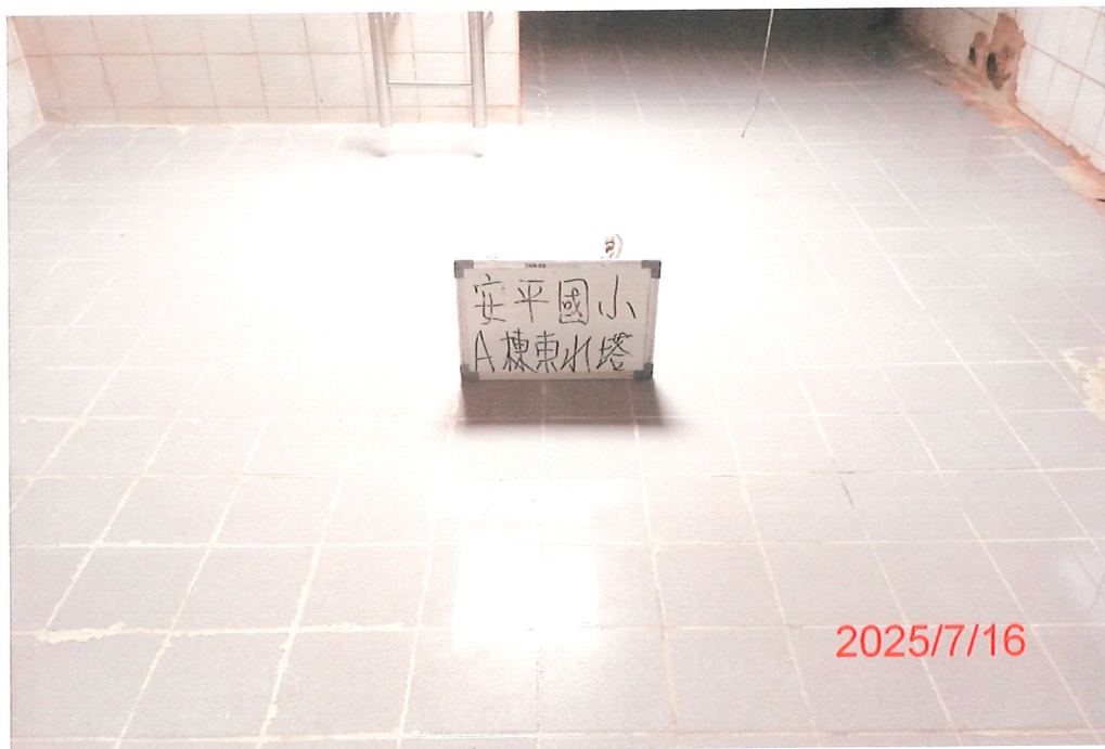
(A棟東)水塔清洗後
