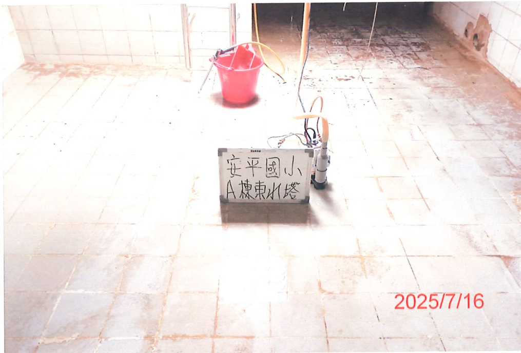
(A棟東)水塔清洗前
