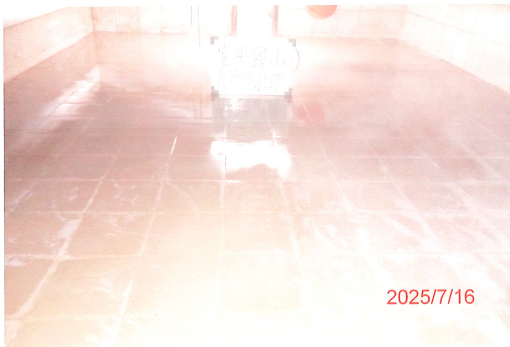
(A棟中)水塔清洗後
