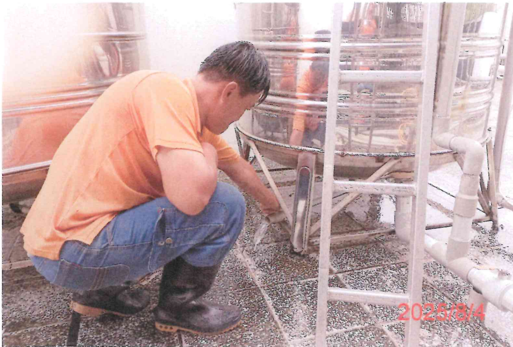
管路檢查作業中
