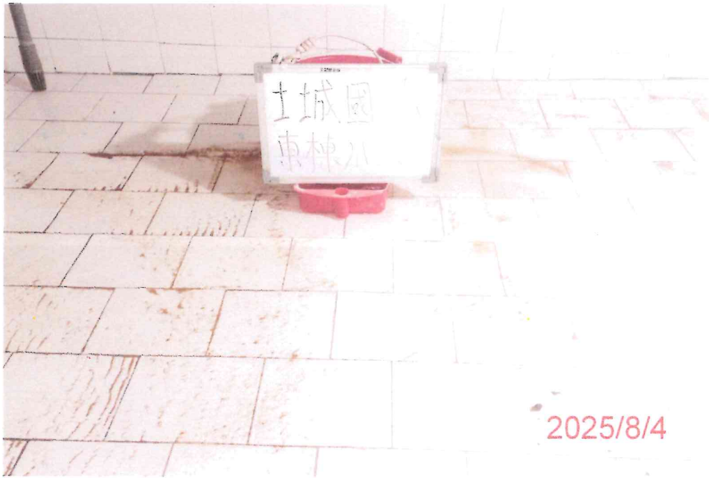
(東棟)水池清洗前
