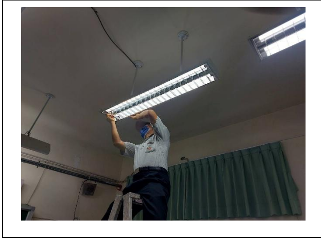
說明：更換不良燈管
