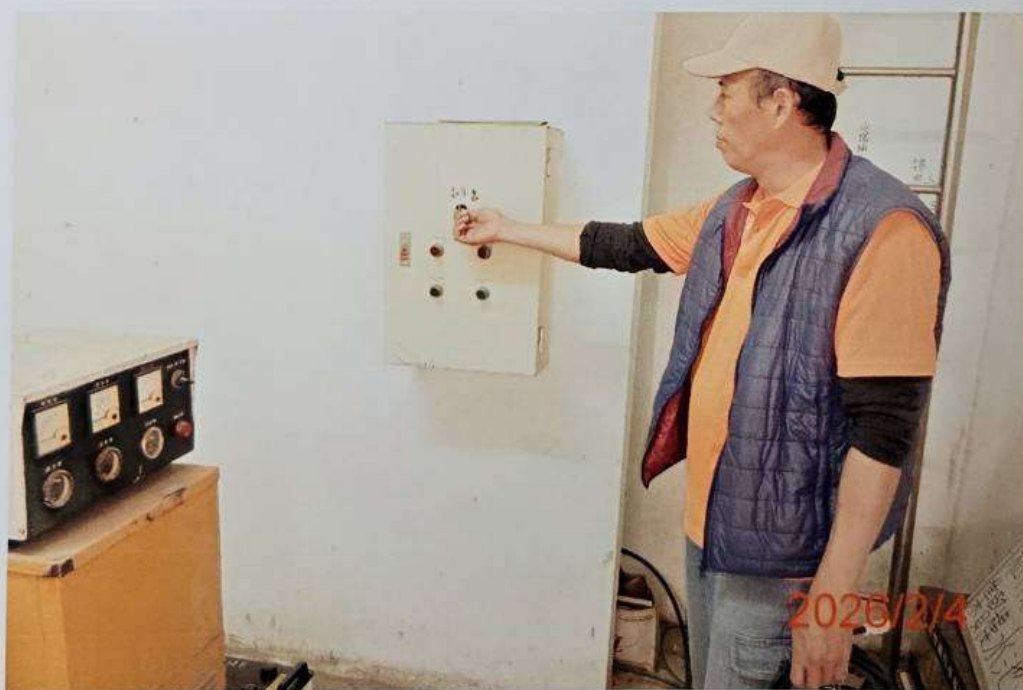
作業後電控檢查
