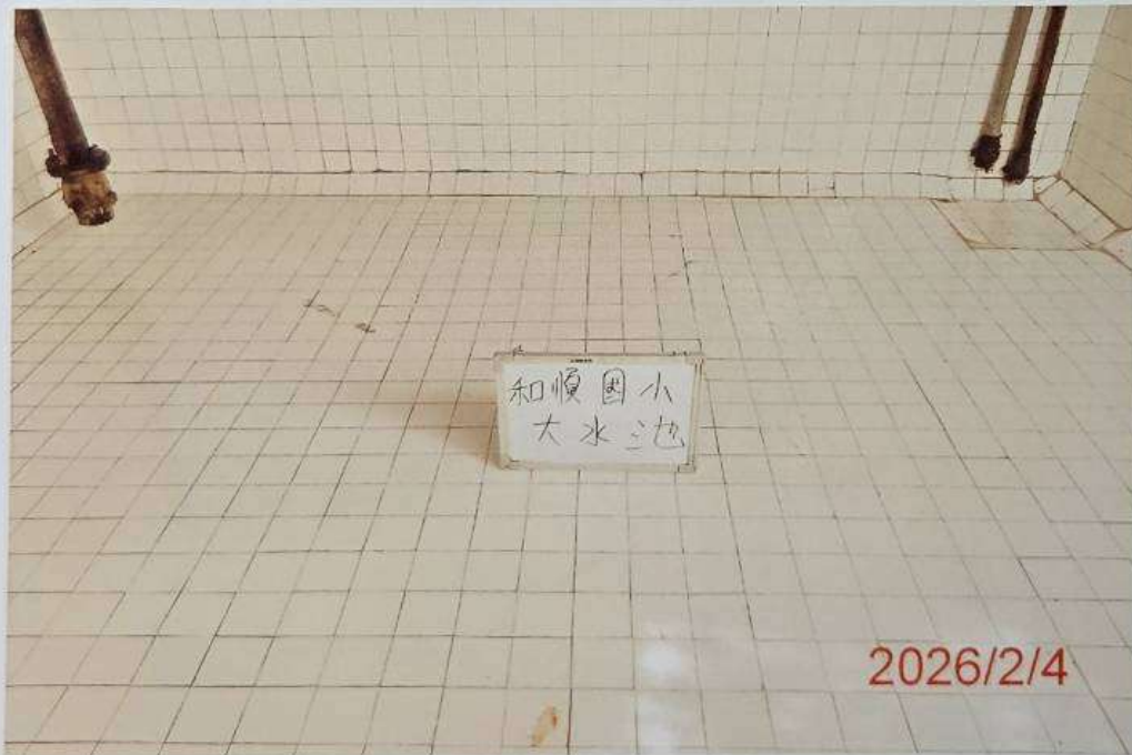
大水池清洗後
