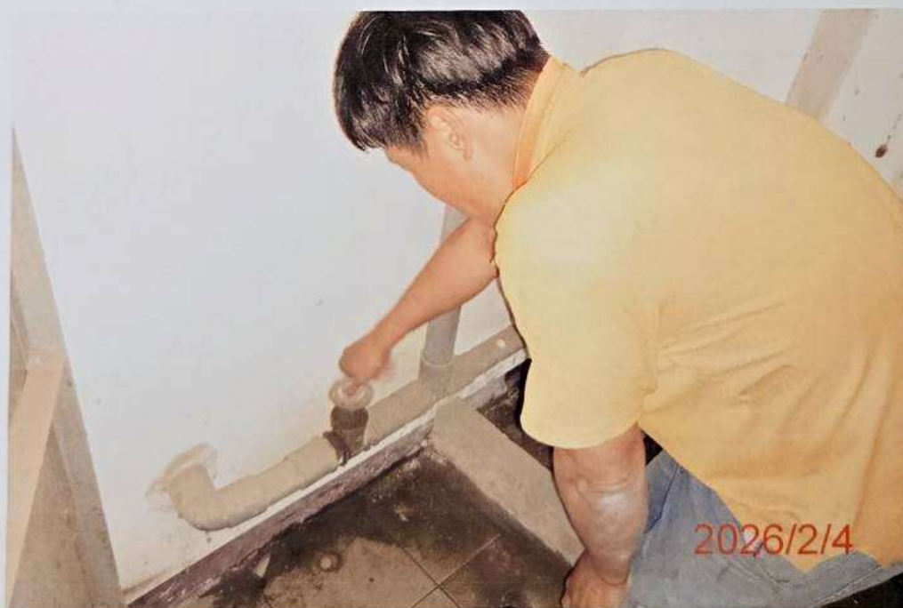
管路檢查作業中
