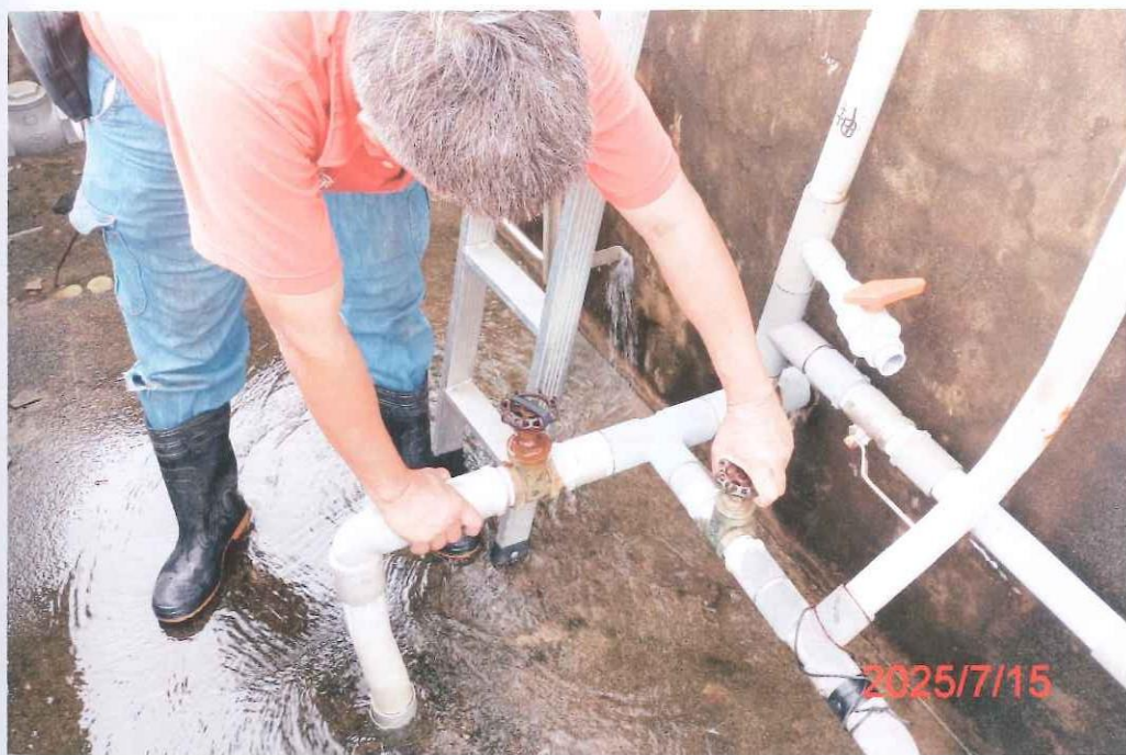
管路檢查作業中
