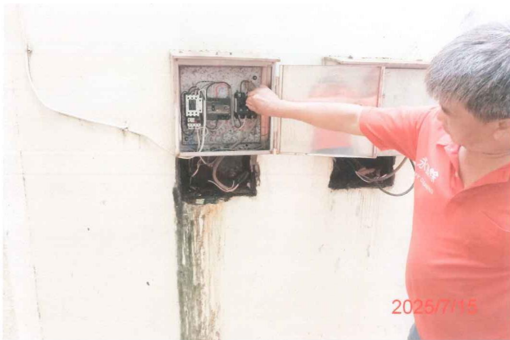
作業後電控檢查
