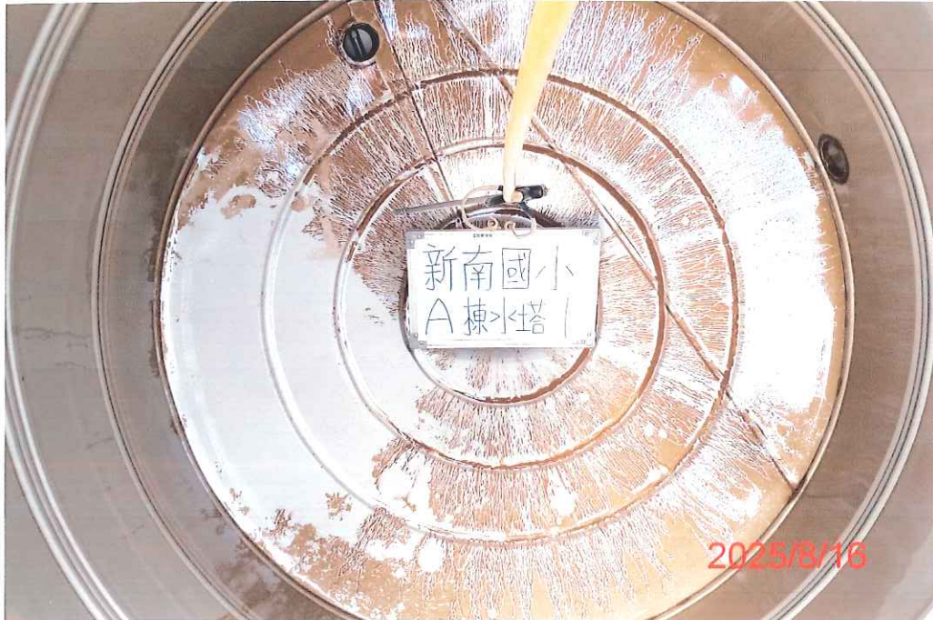
(A棟-1)水塔清洗前
