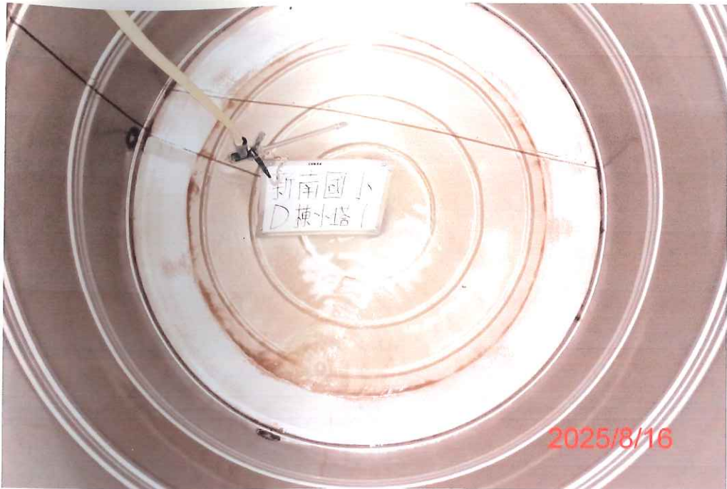
(D棟-1)水塔清洗前
