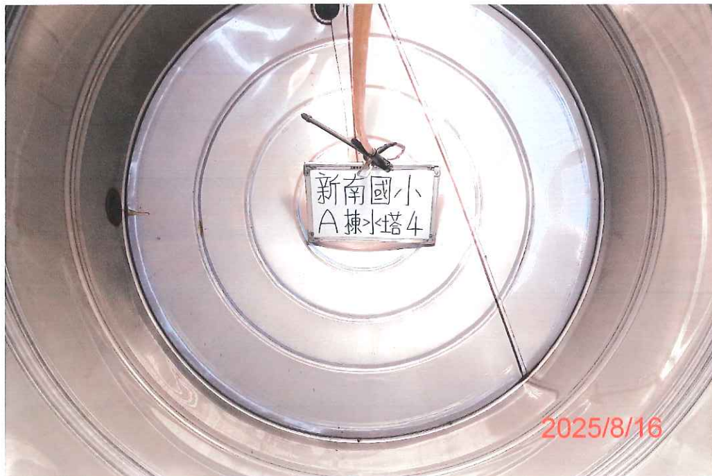
(A棟-4)水塔清洗後
