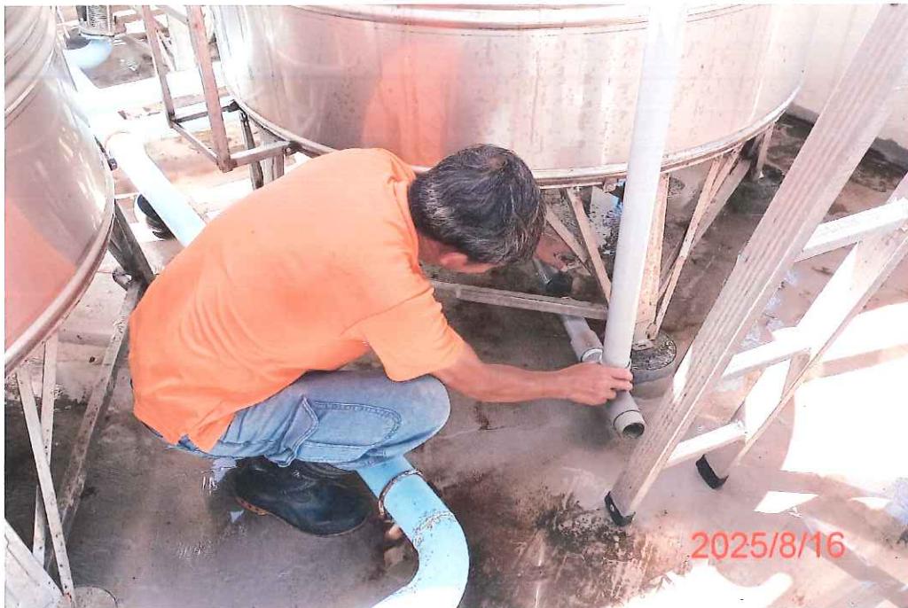
管路檢查作業中
