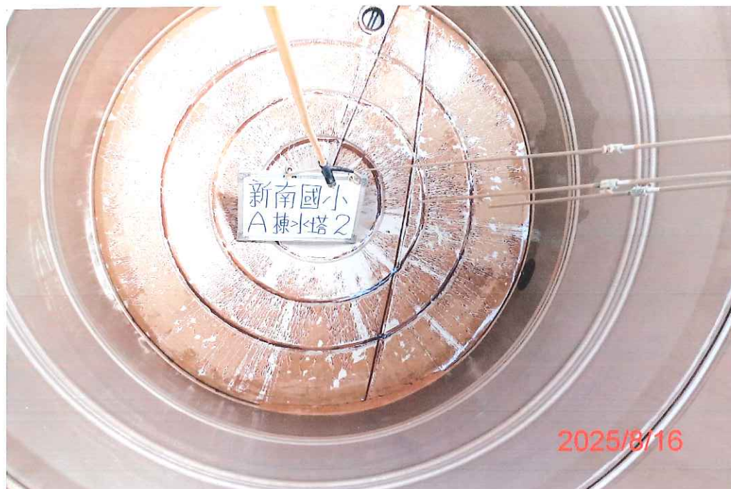
(A棟-2)水塔清洗前
