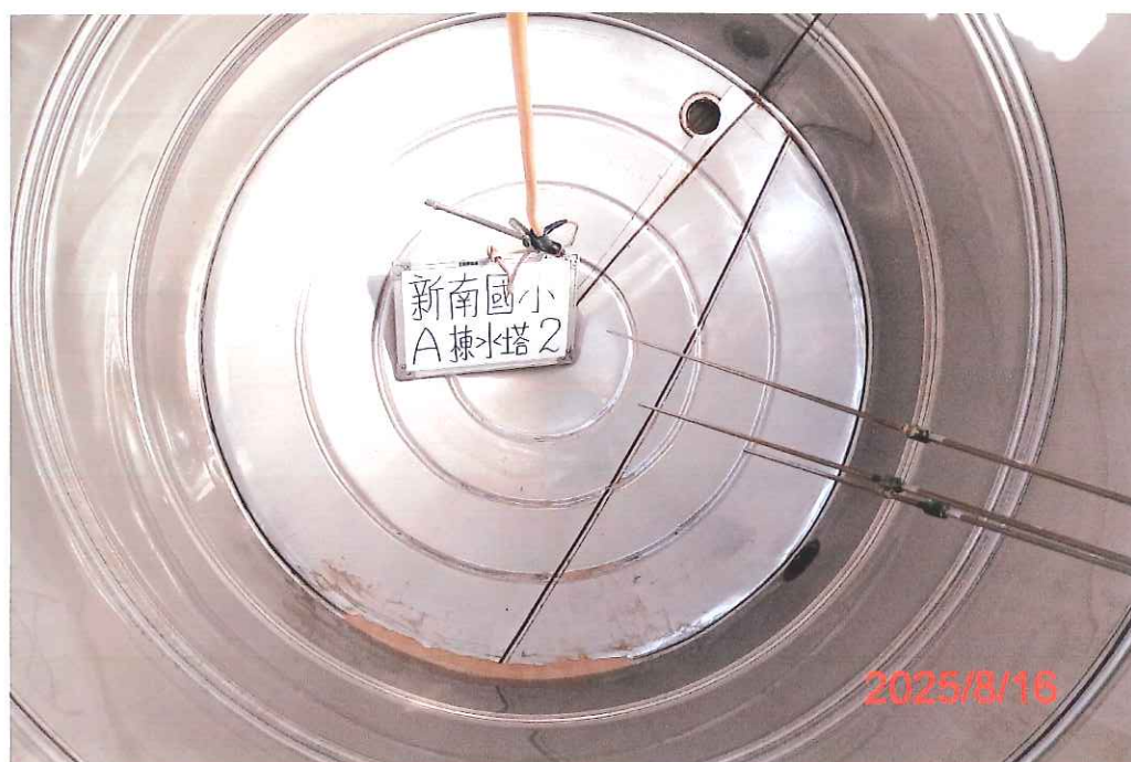
(A棟-2)水塔清洗後
