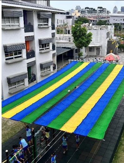
遊戲場架設遮陽網
