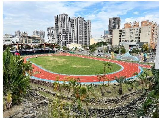
操場跑道工程(完工)
