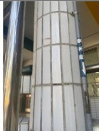
兩水收集系統：於學校南棟及北棟教室設置集雨管，提供各班平日澆灌班級花台使用。
