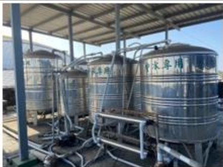
中水處理系統提供南北棟廁所沖洗用水
