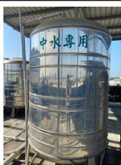
中水處理系統提供南北棟廁所沖洗用水
