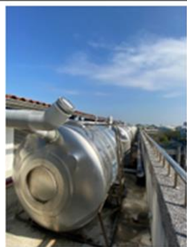
中水處理系統提供南北棟廁所沖洗用水
