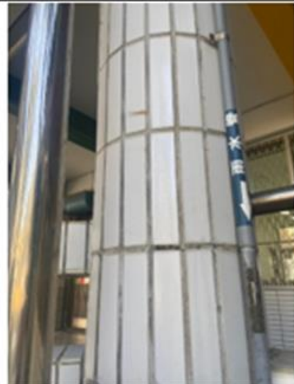
雨水收集系統：於學校南棟及北棟教室設置集雨管，提供各班平日澆灌班級花台使用。
