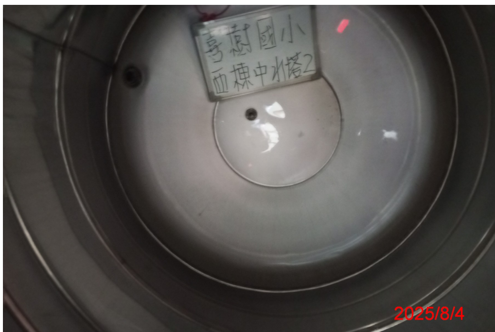
西棟中水塔 2 清洗後
