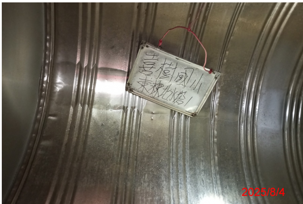
東棟水塔 1 清洗後
