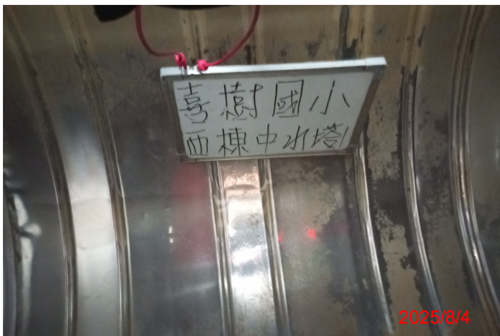
西棟中水塔 1 清洗後
