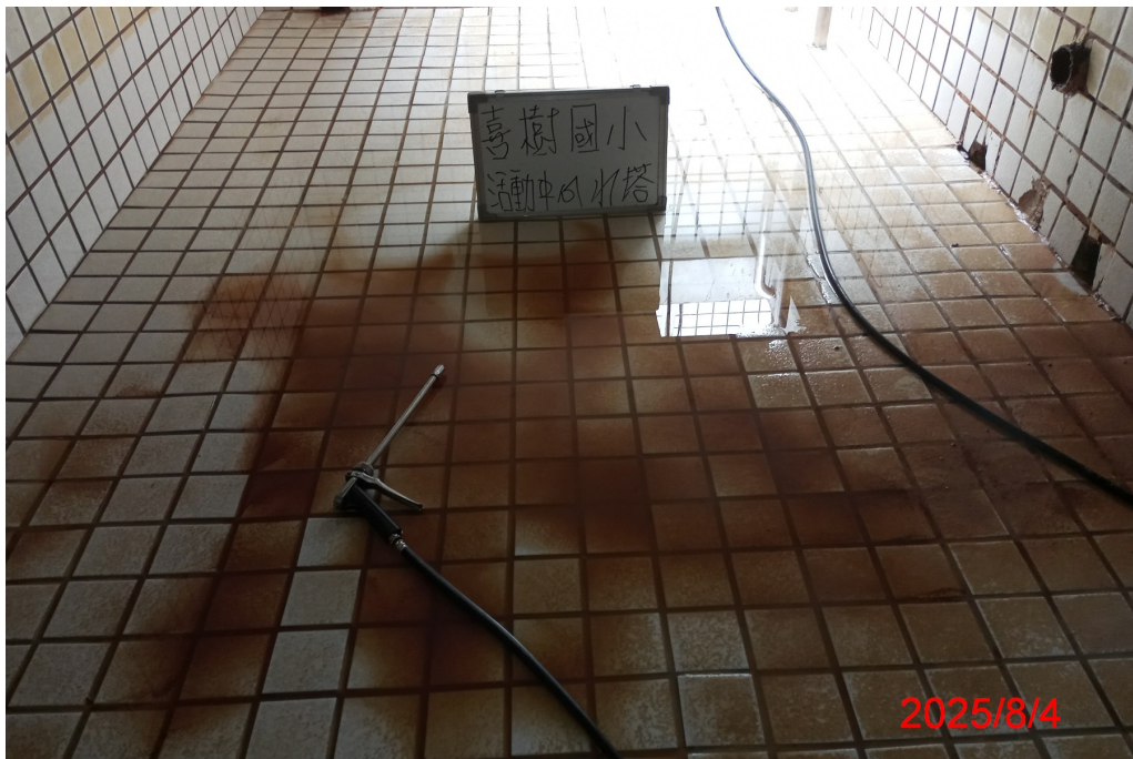
活動中心水塔清洗前
