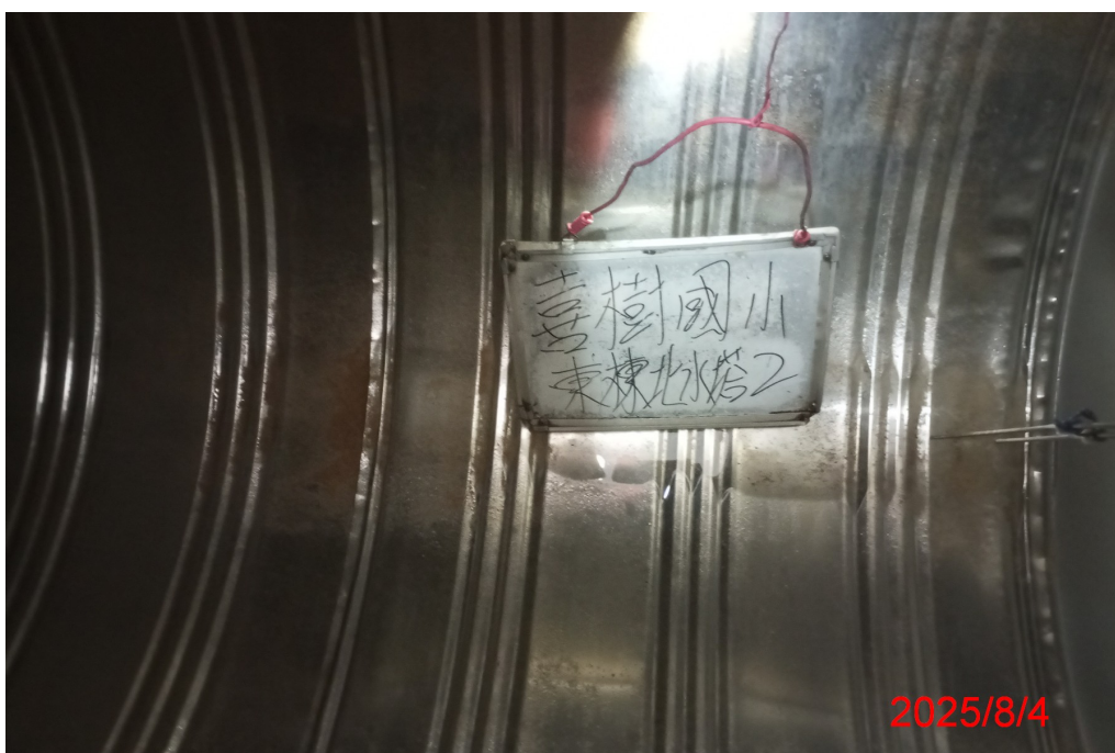
東棟水塔 2 清洗後
