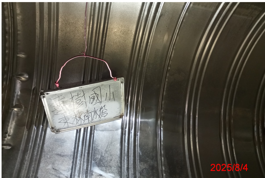
東棟南水塔清洗後
