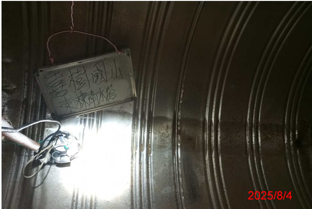
東棟南水塔清洗前
