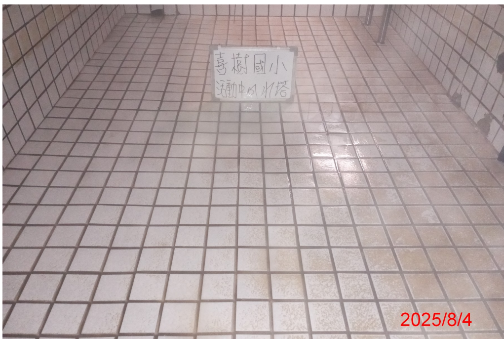
活動中心水塔清洗後
