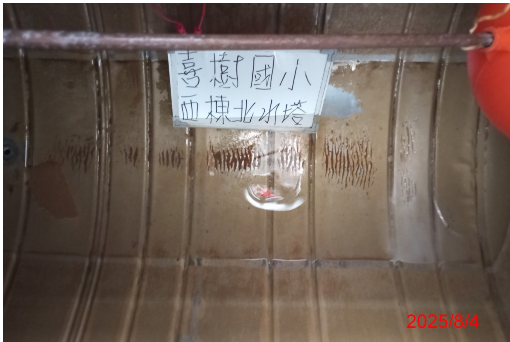
西棟北水塔清洗前
