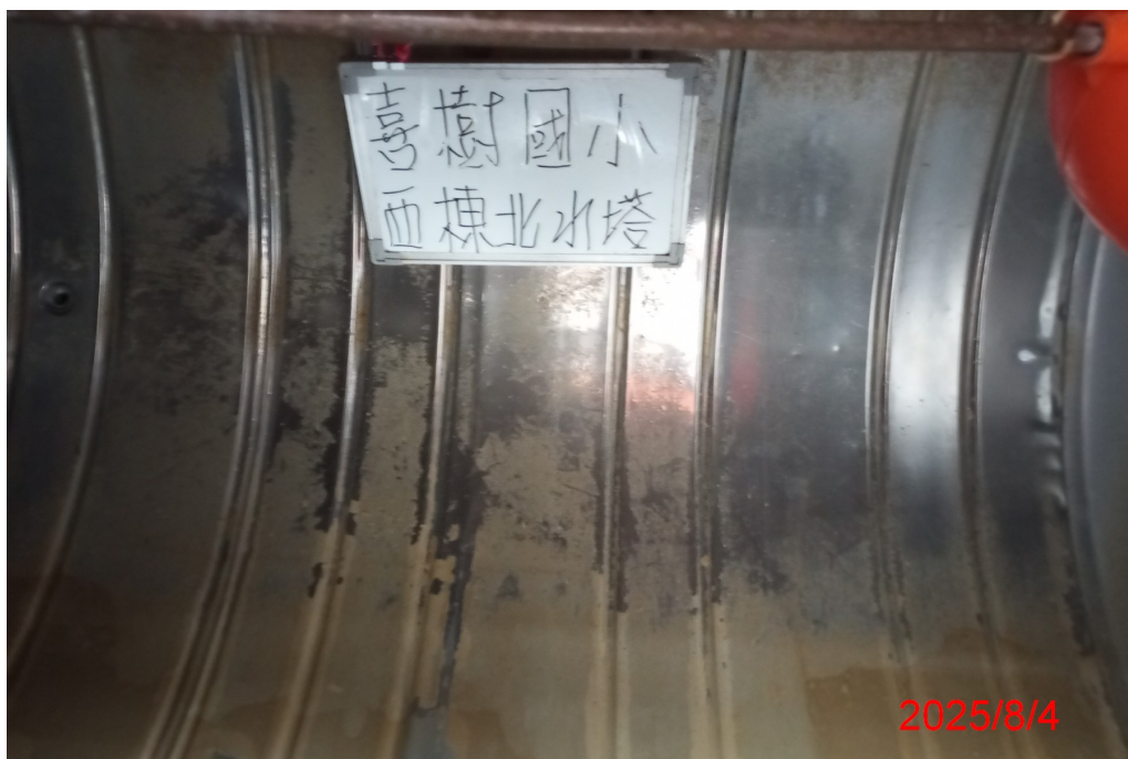
西棟北水塔清洗後
