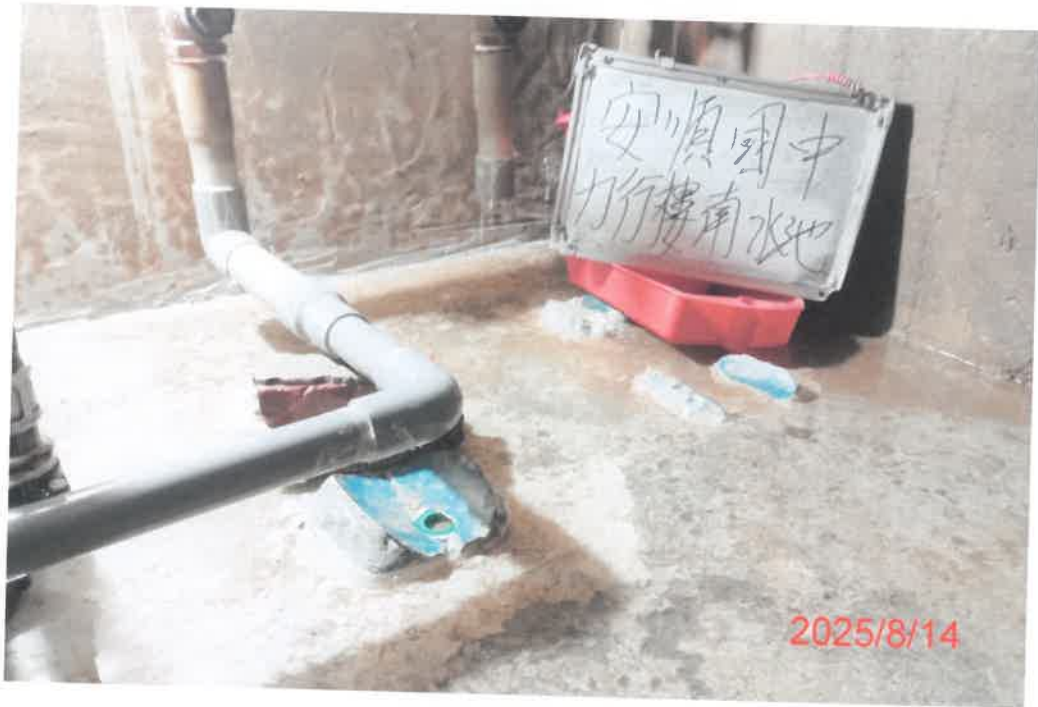
(力行樓南)水池清洗前
