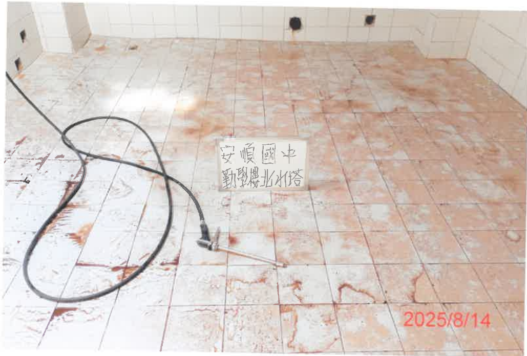
(勤學樓北)水塔清洗前
