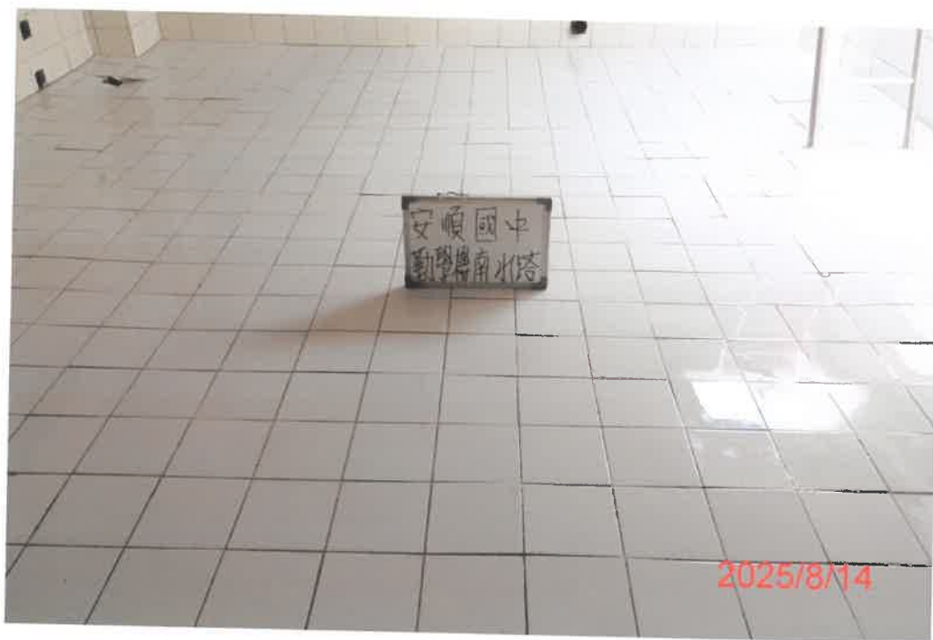
(勤學樓南)水塔清洗後
