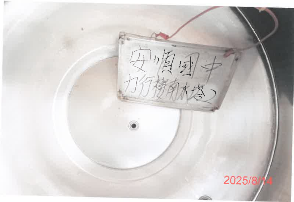
(力行樓南-2)水塔清洗前
