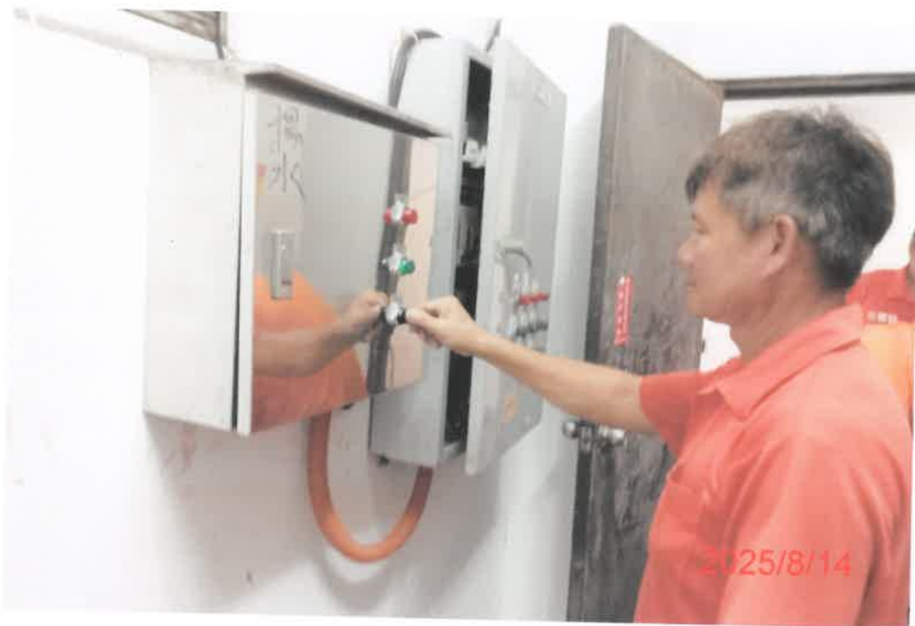
作業後電控檢查
