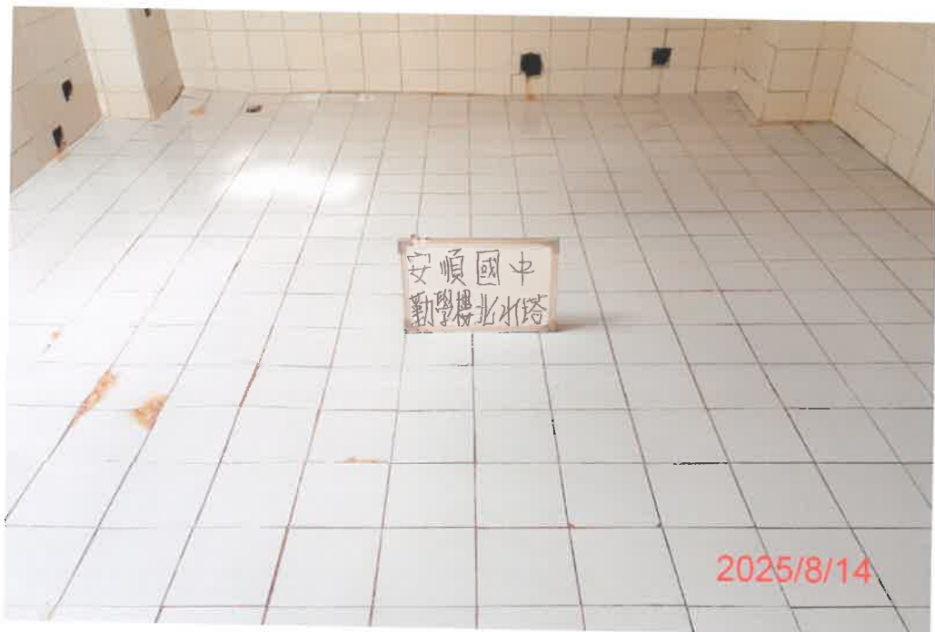
(勤學樓北)水塔清洗後
