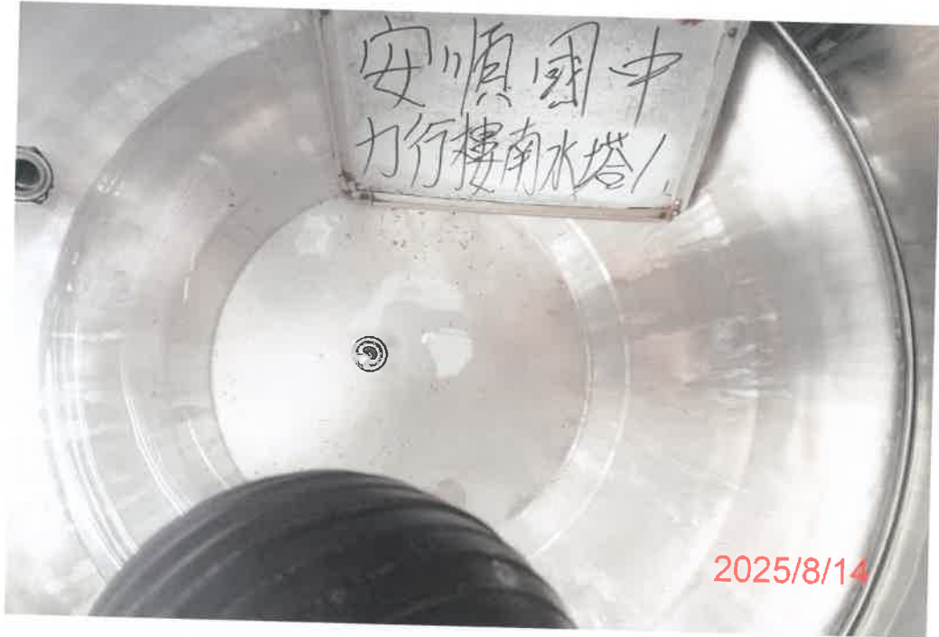
(力行樓南-1)水塔清洗前
