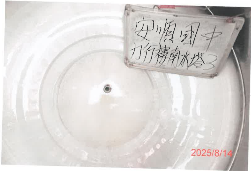
(力行樓南-3)水塔清洗前
