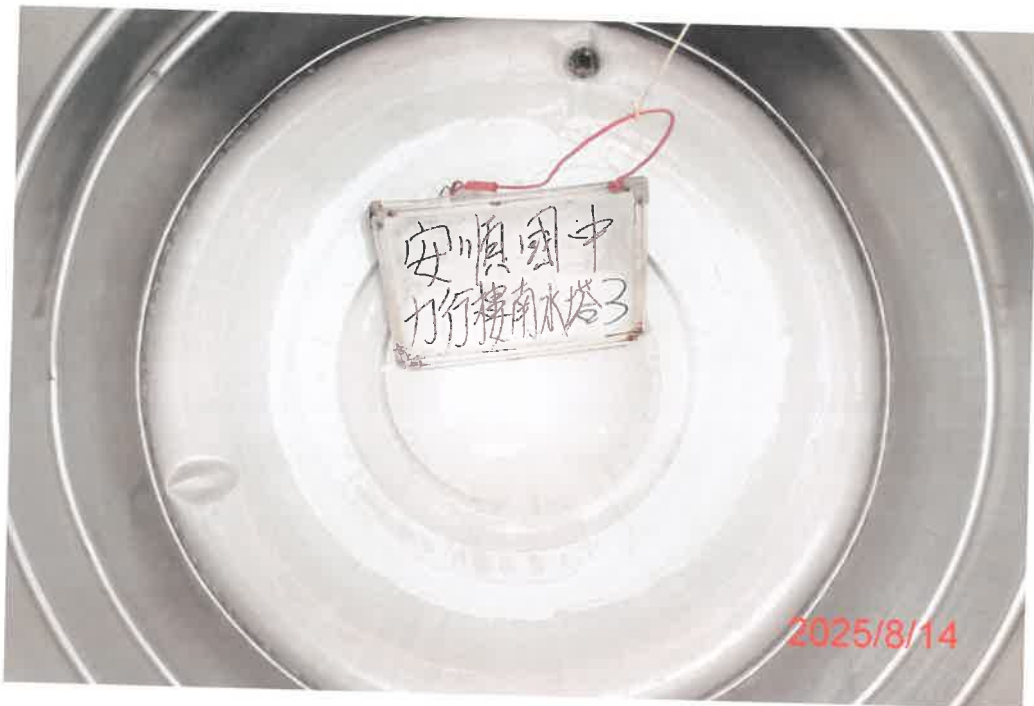
(力行樓南-3)水塔清洗後
