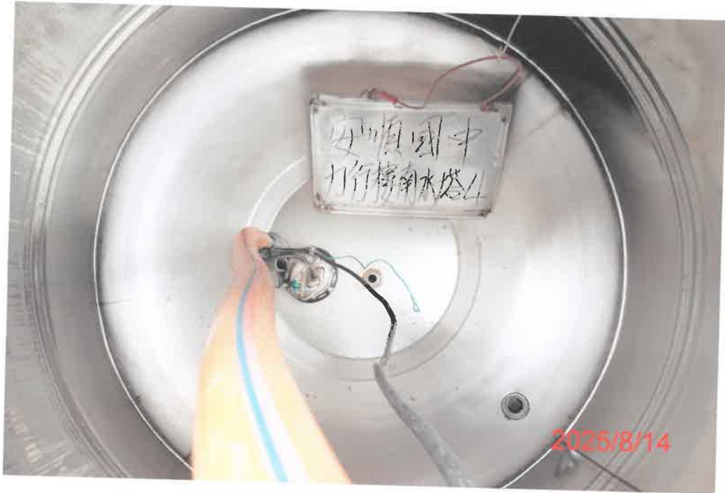
(力行樓南-4)水塔清洗前
