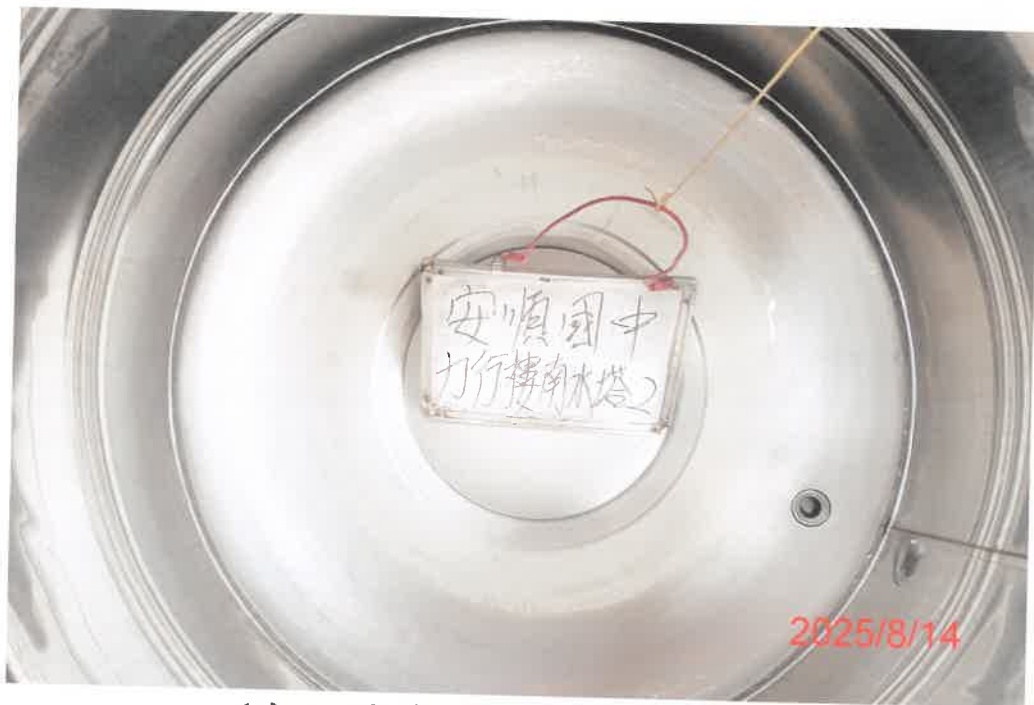
(力行樓南-2)水塔清洗後
