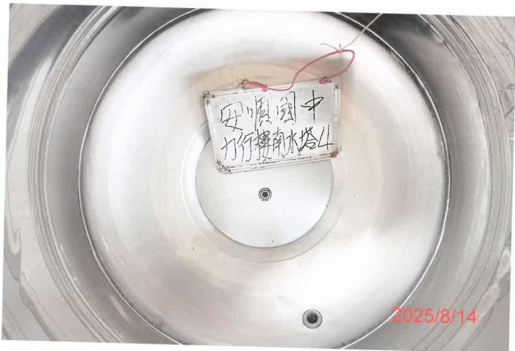
(力行樓南-4)水塔清洗後
