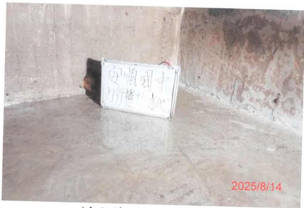
(力行樓北)水池清洗後
