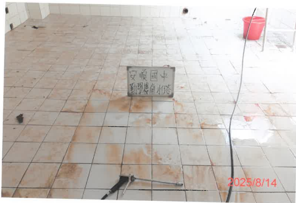
(勤學樓南)水塔清洗前
