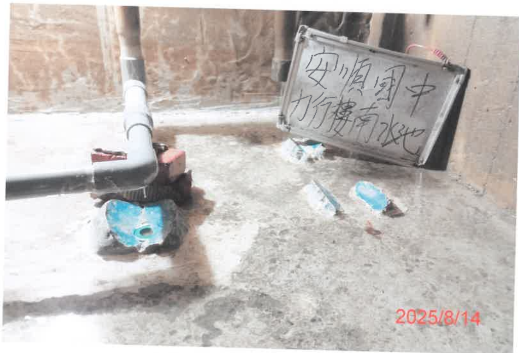
(力行樓南)水池清洗後
