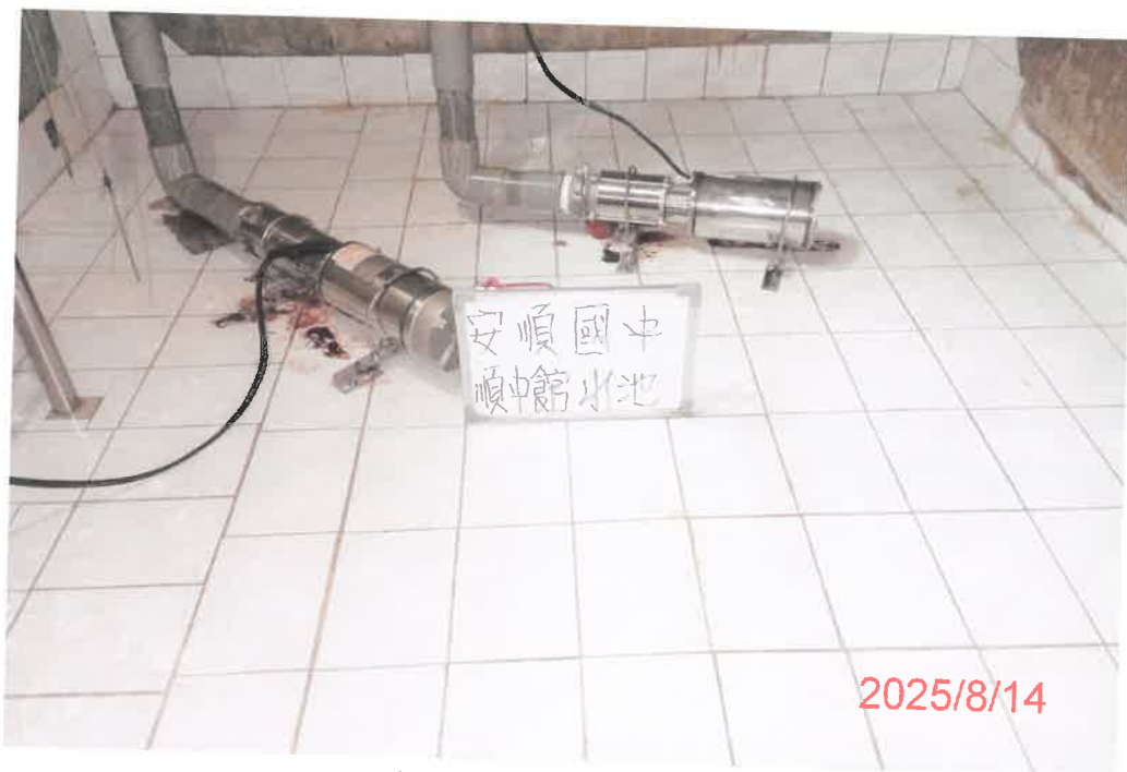
(順中館)水池清洗後
