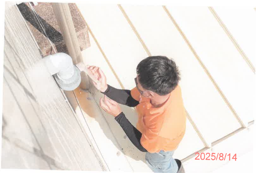
管路檢查作業中
