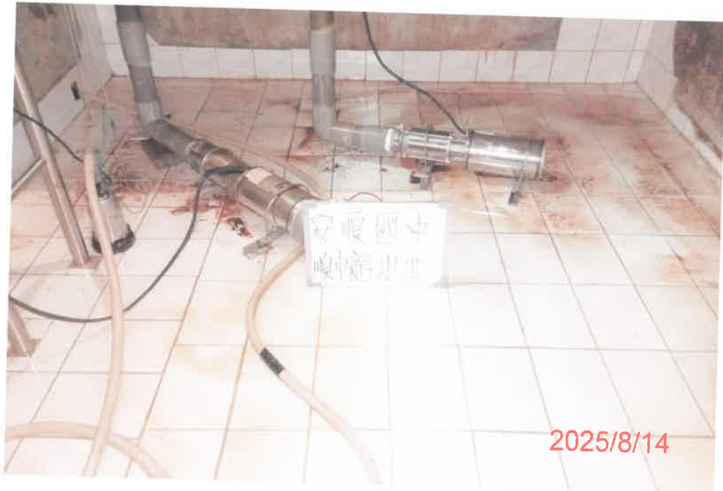
(順中館)水池清洗前
