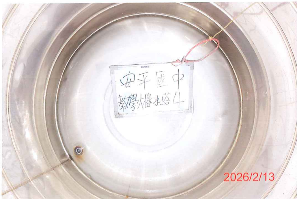
(教學大樓-4)水塔清洗後
