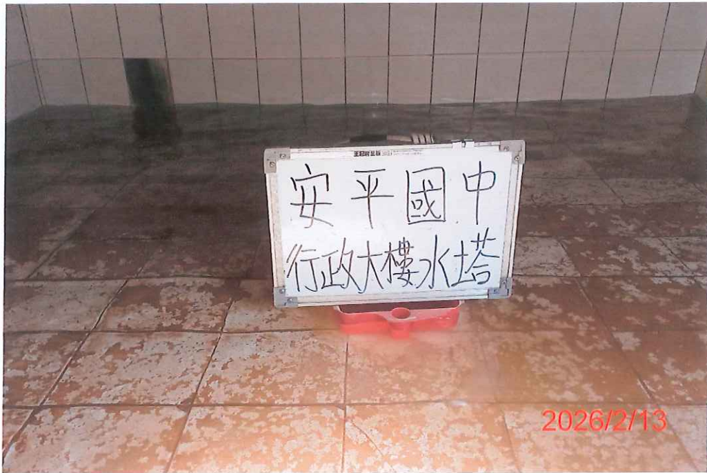
(行政大樓)水塔清洗前
