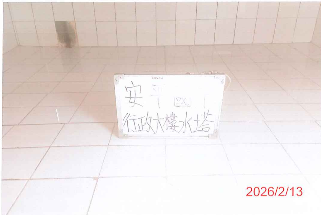
(行政大樓)水塔清洗後
