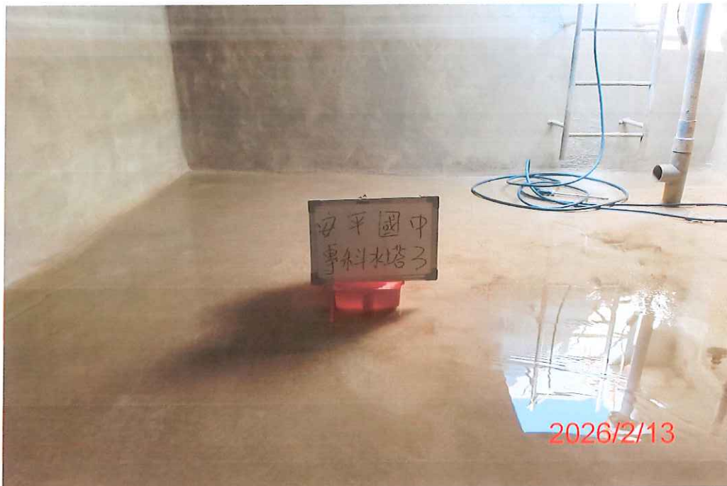
(專科大樓-3)水塔清洗前
