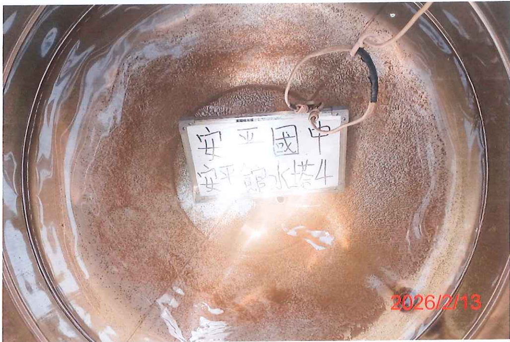
(安平館-4)水塔清洗前
