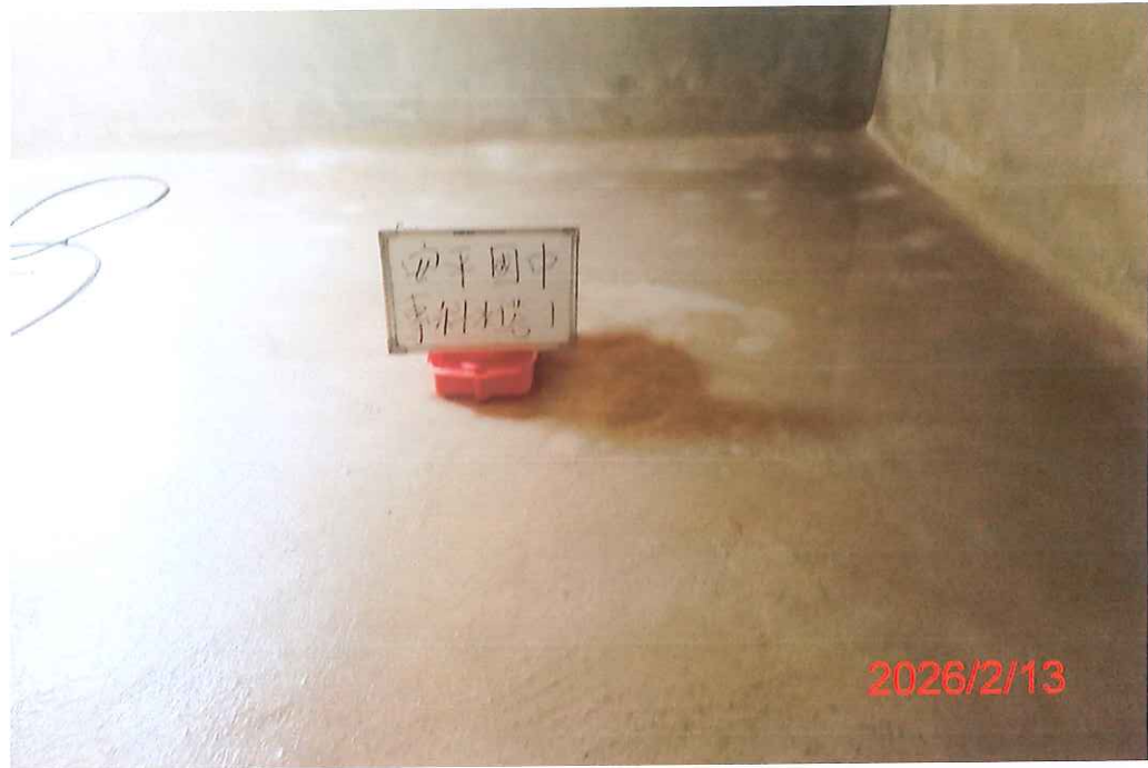
(專科大樓-1)水塔清洗前
