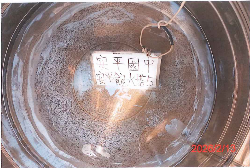
(安平館-5)水塔清洗前
