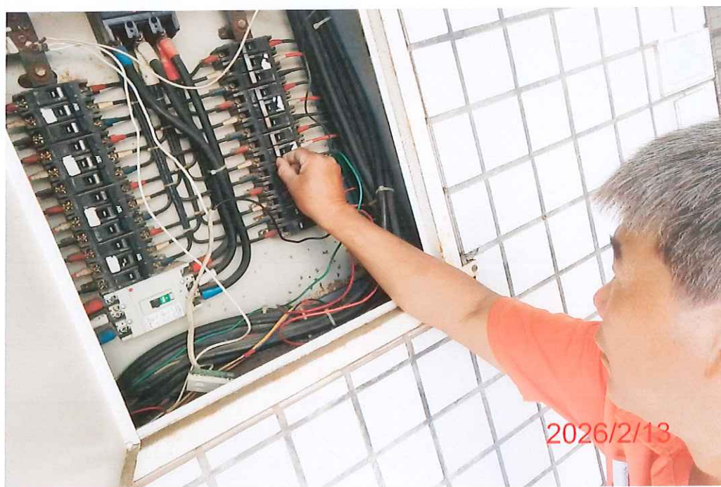
作業後電控檢查
