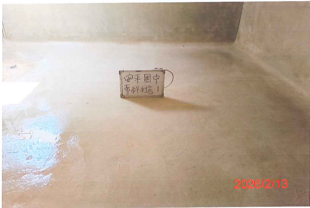
(專科大樓-1)水塔清洗後
