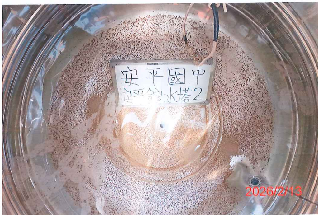
(安平館-2)水塔清洗前
