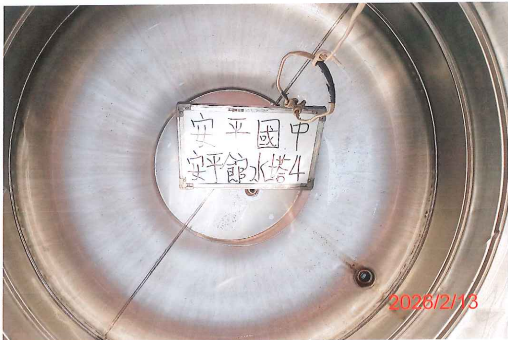
(安平館-4)水塔清洗後
