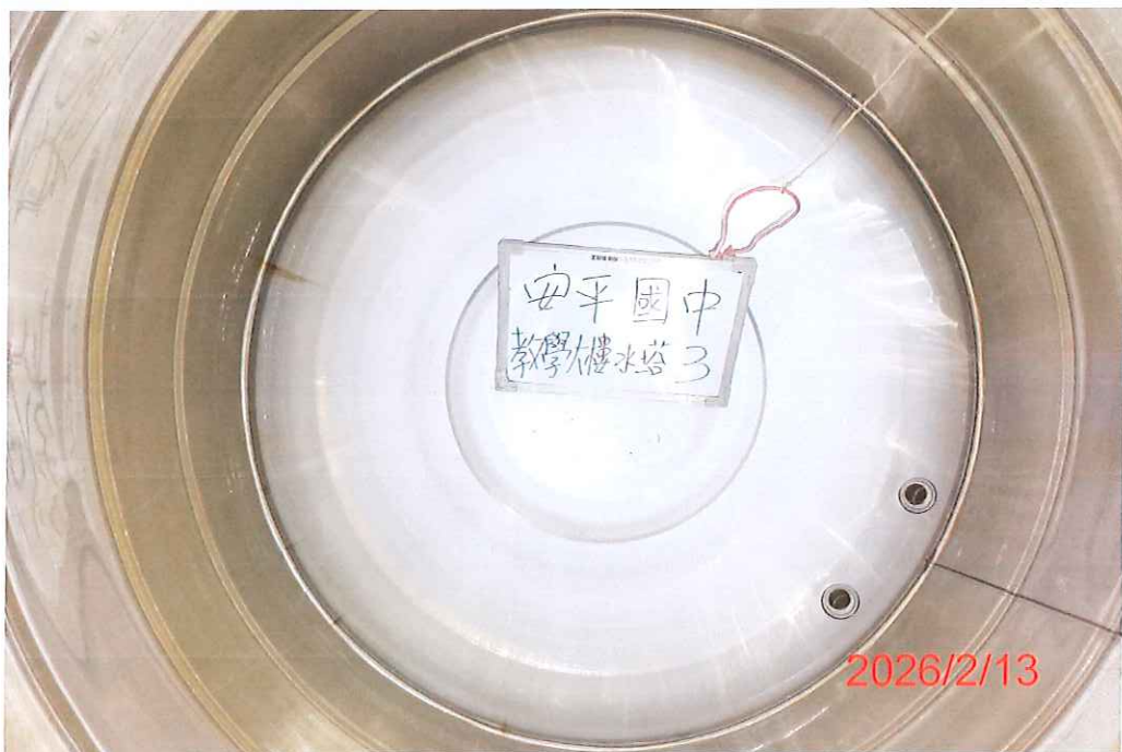
(教學大樓-3)水塔清洗後
