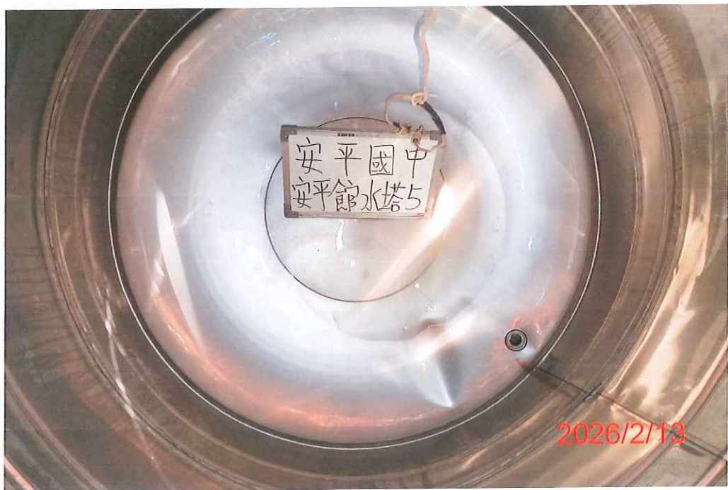
(安平館-5)水塔清洗後
