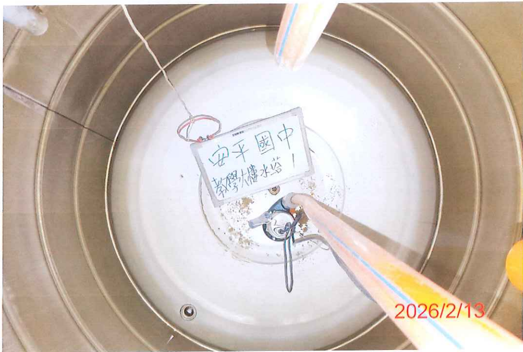
(教學大樓-1)水塔清洗前
