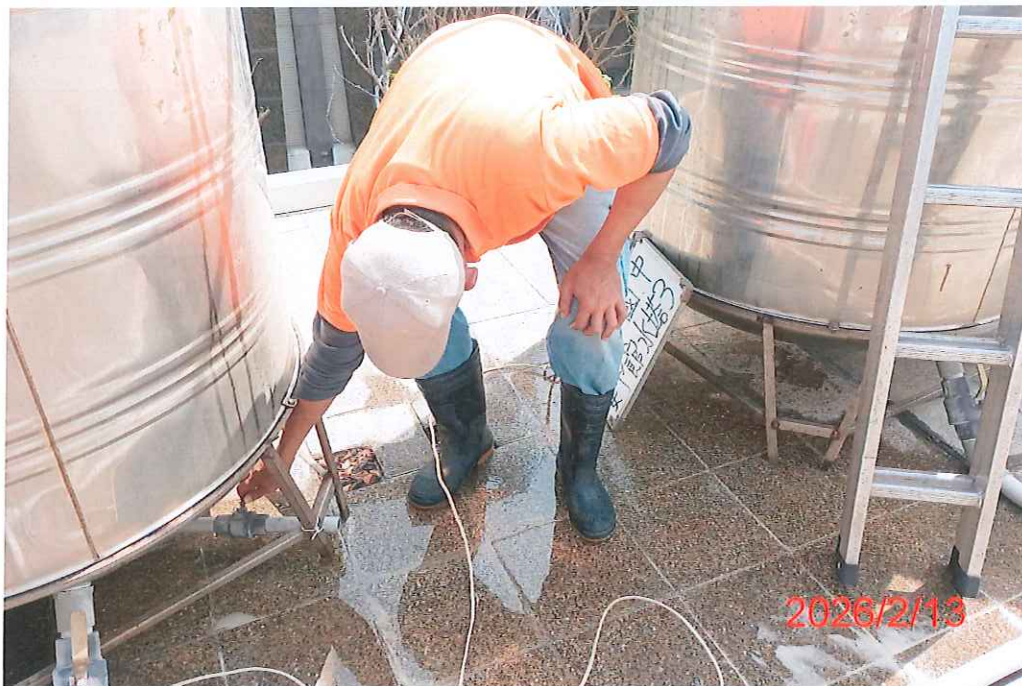
管路檢查作業中
