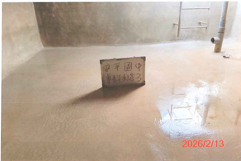
(專科大樓-3)水塔清洗後
