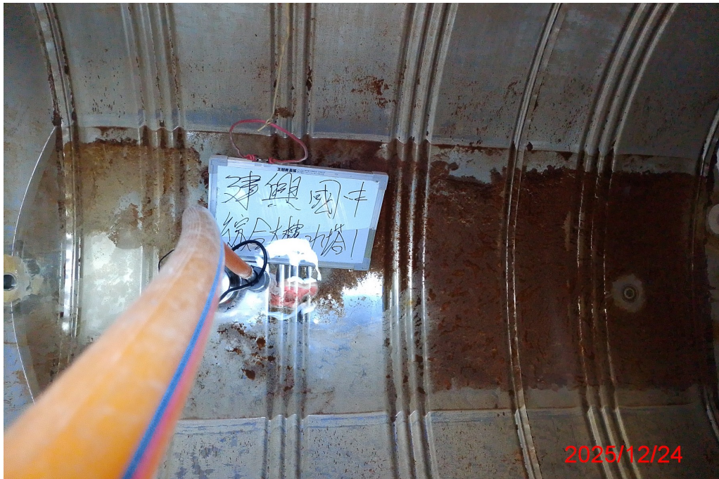
綜合大樓水塔 1 清洗前
