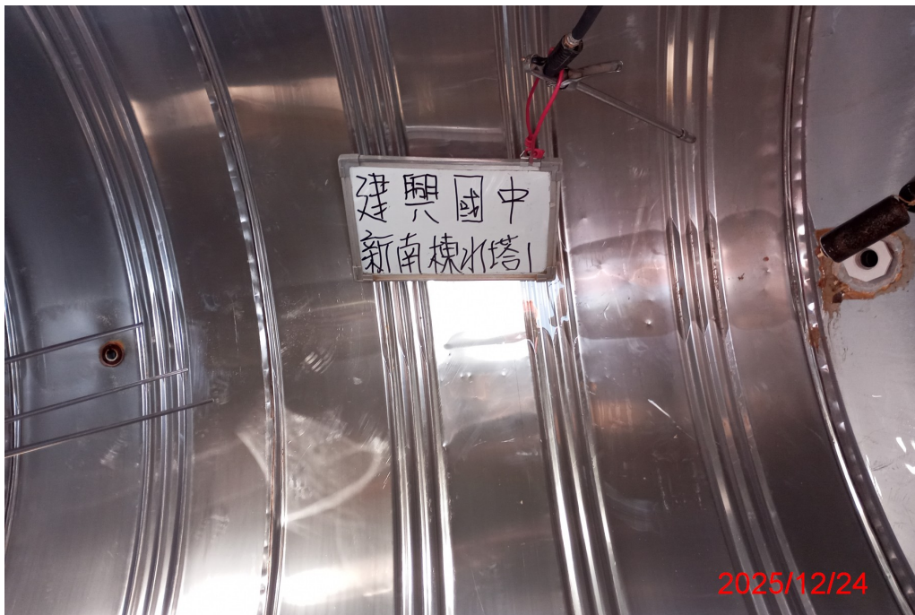
新南棟水塔 1 清洗後
