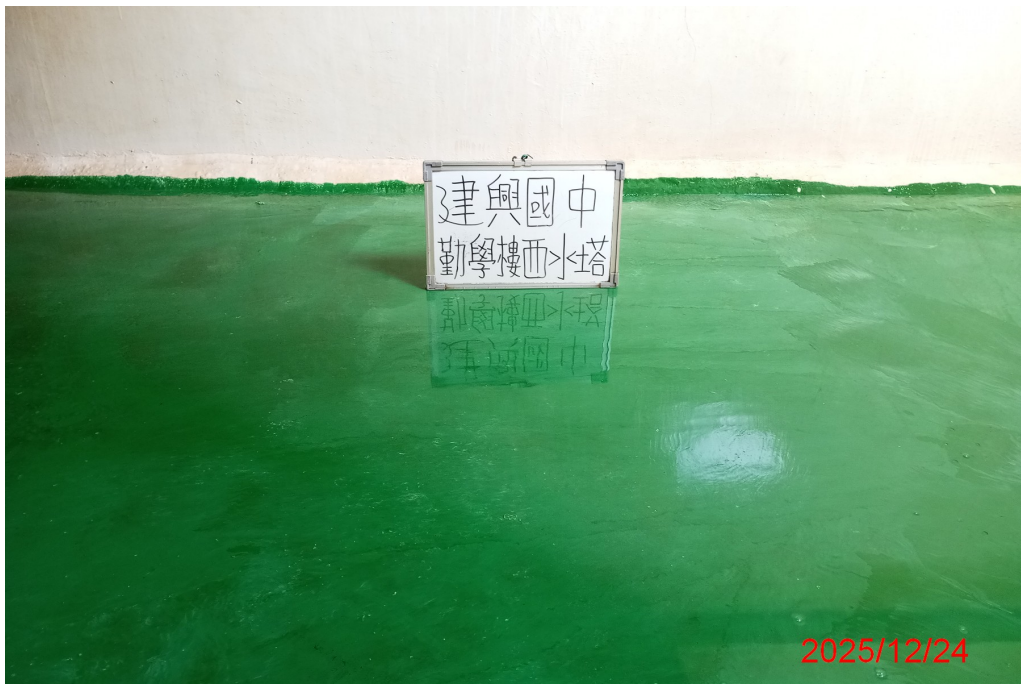
勤學樓西水塔清洗後
