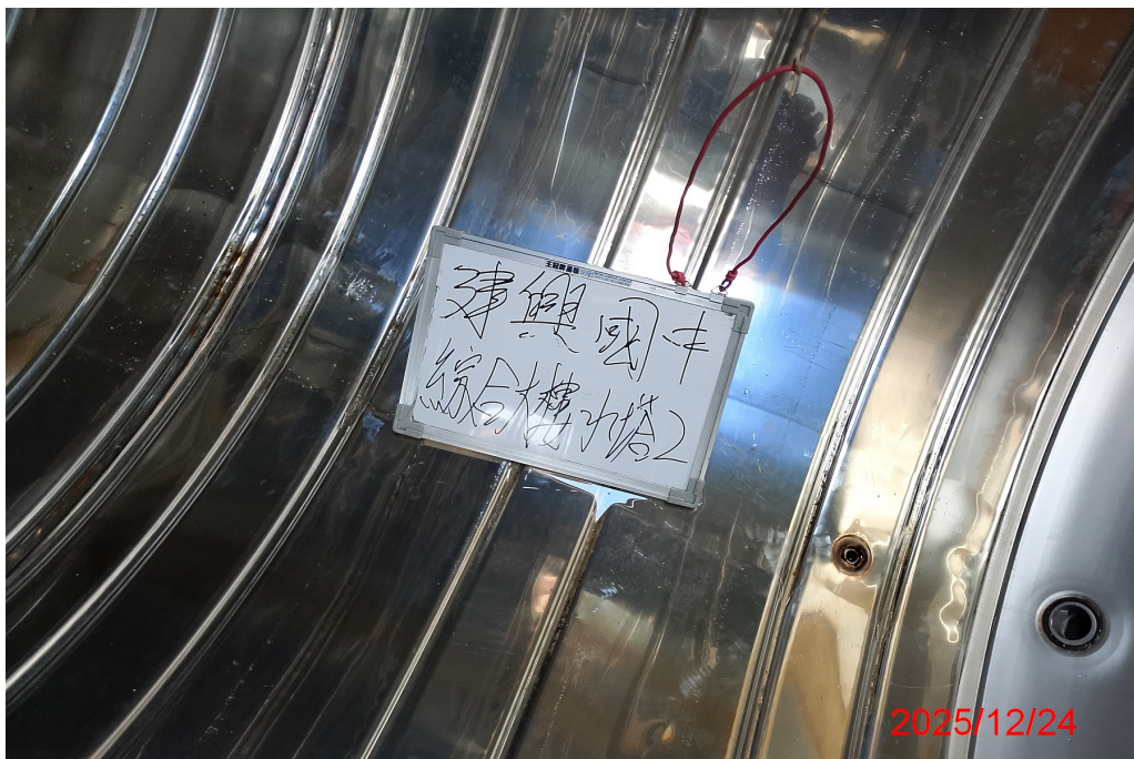
綜合大樓水塔 2 清洗後
