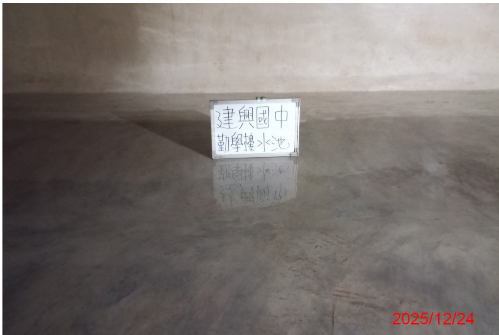
勤學樓水池清洗後
