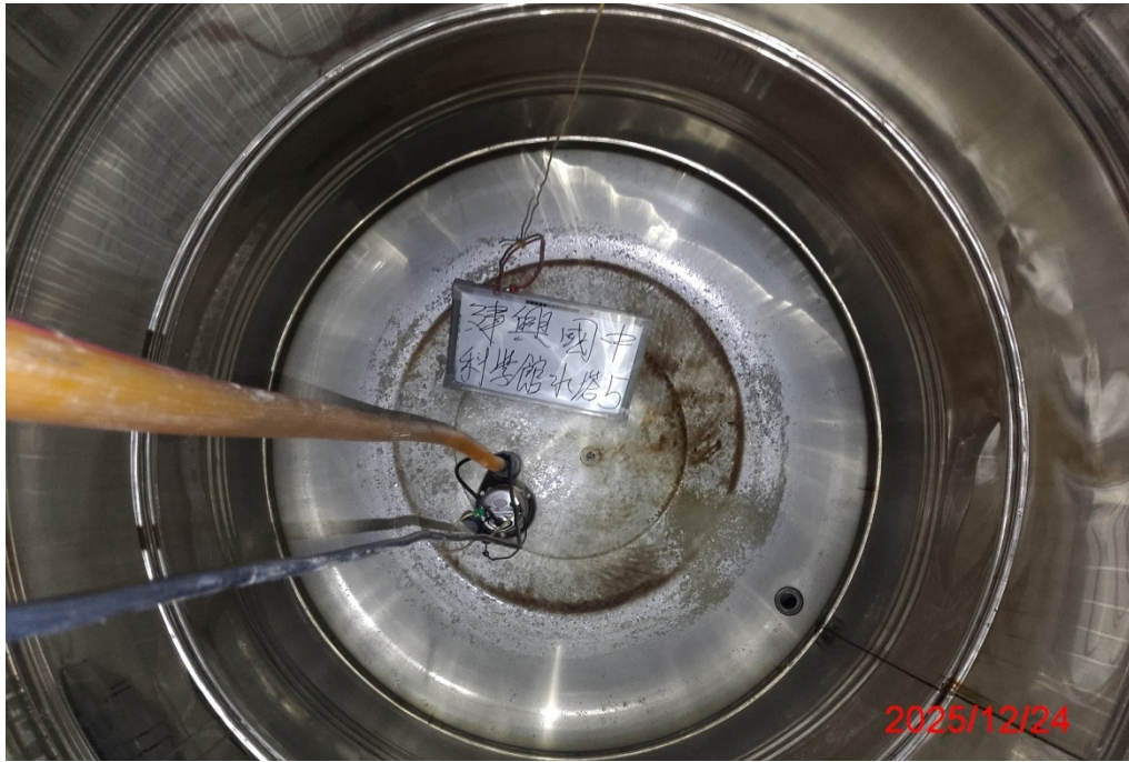
科學館水塔 5 清洗前
