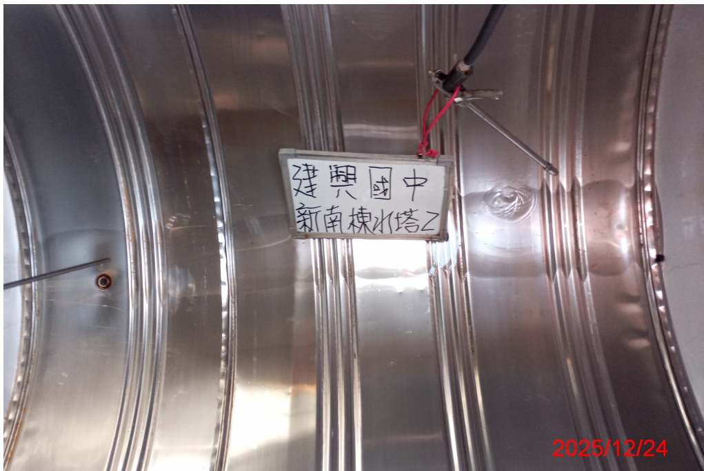
新南棟水塔 2 清洗後
