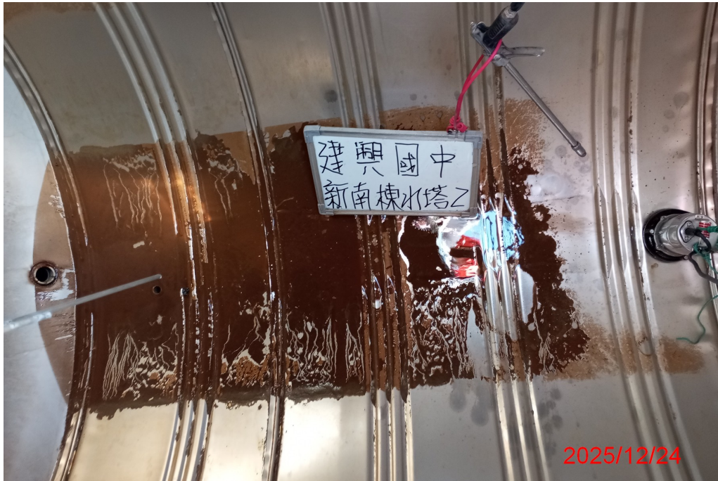
新南棟水塔 2 清洗前
