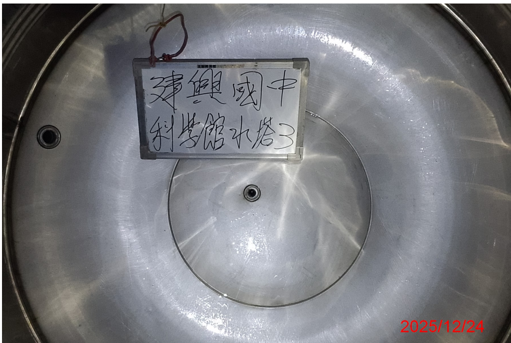
科學館水塔 3 清洗後
