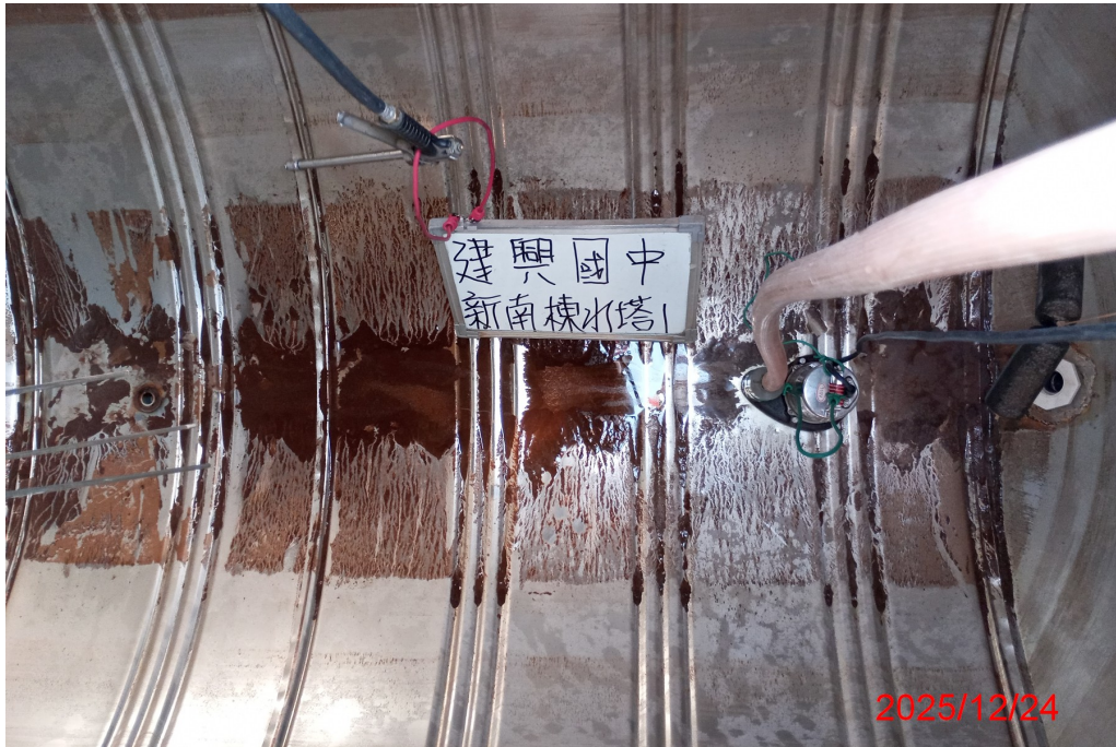
新南棟水塔 1 清洗前
