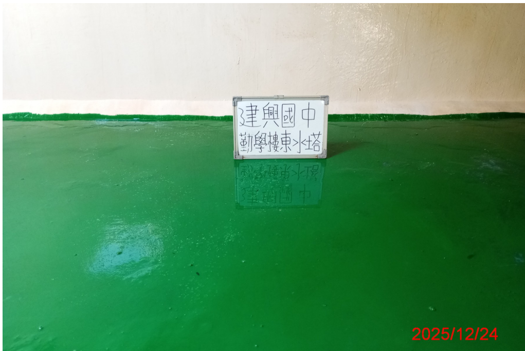
勤學樓東水塔清洗後
