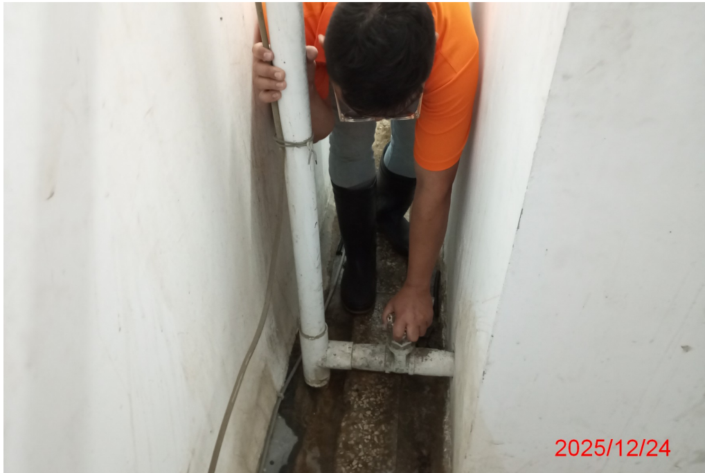
清洗後管路檢查
