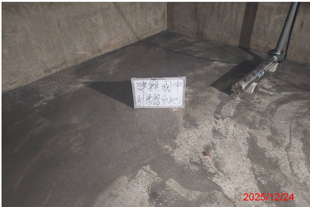
科學樓水池清洗後
