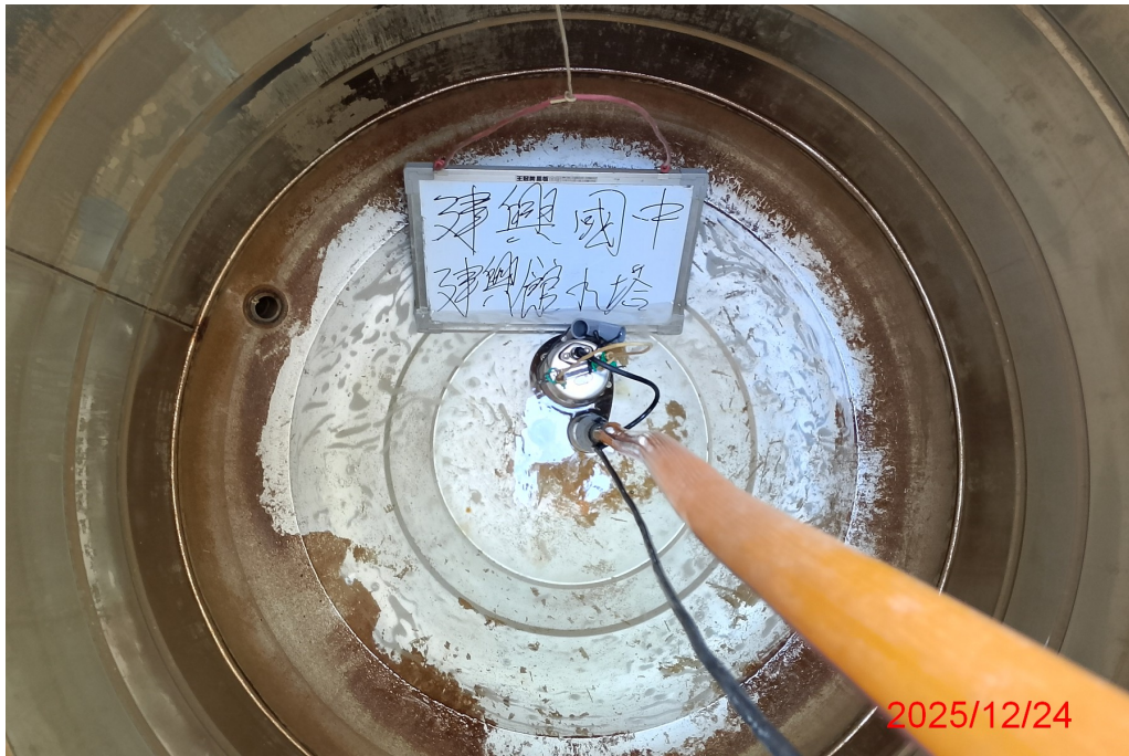
建興館水塔清洗前
