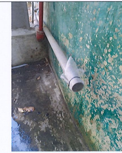
風雨球場積水水管加網
