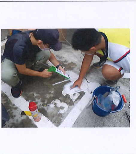
水泥破洞處矽利康封蓋
