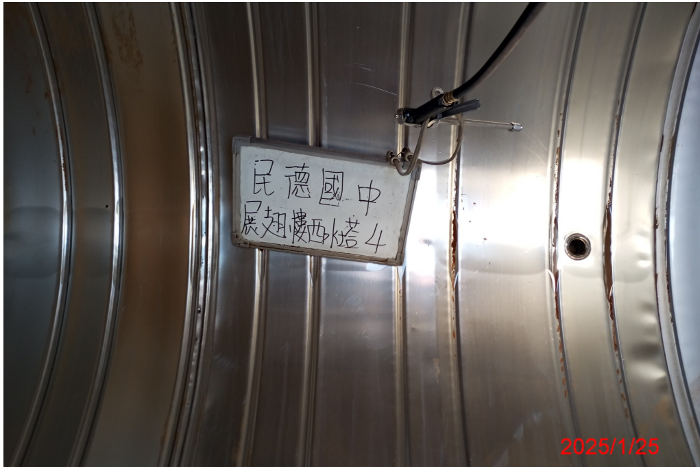
展翅樓西水塔 4 清洗前
