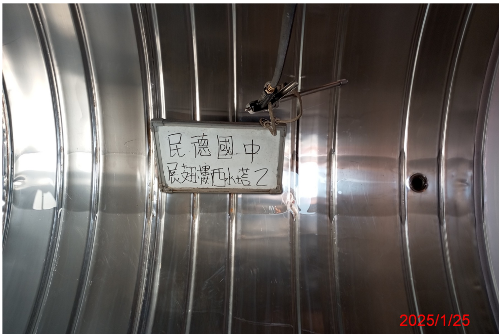
展翅樓西水塔 2 清洗後
