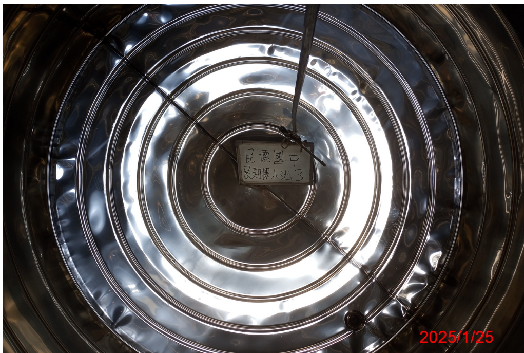
展翅樓水池 3 清洗後
