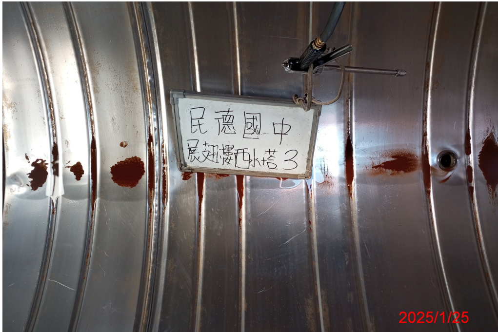
展翅樓西水塔 3 清洗前
