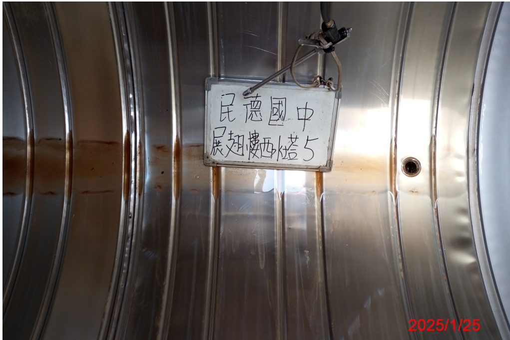
展翅樓西水塔 5 清洗前
