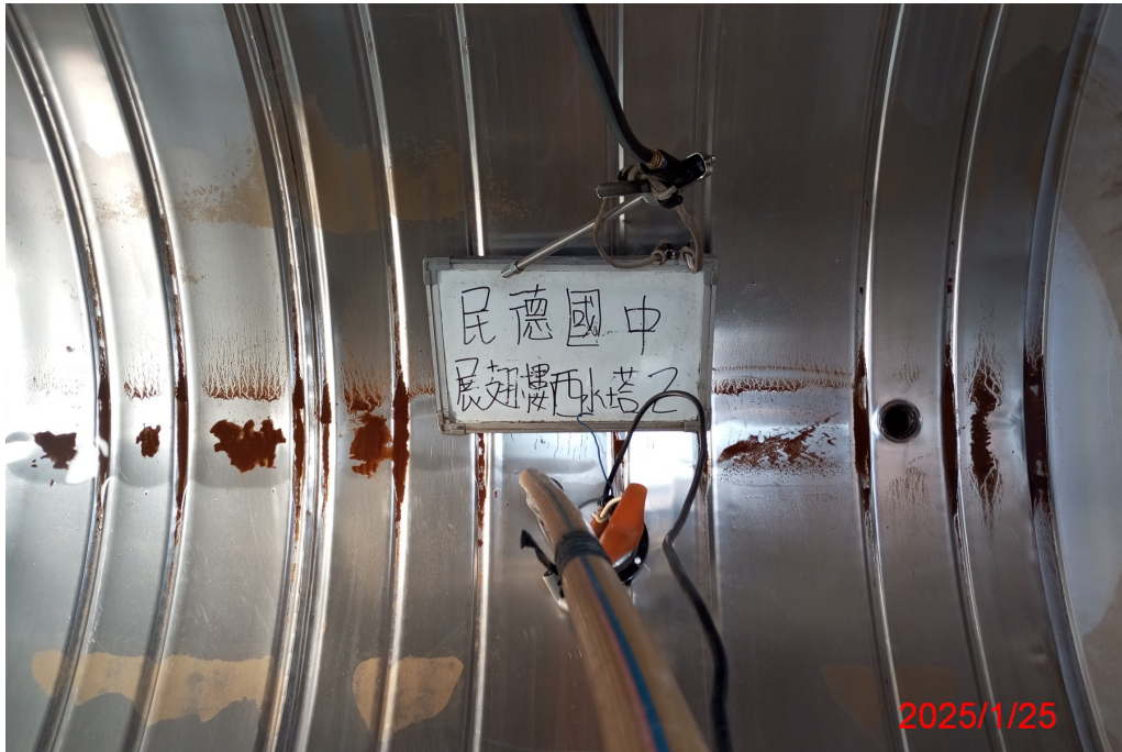
展翅樓西水塔 2 清洗前
