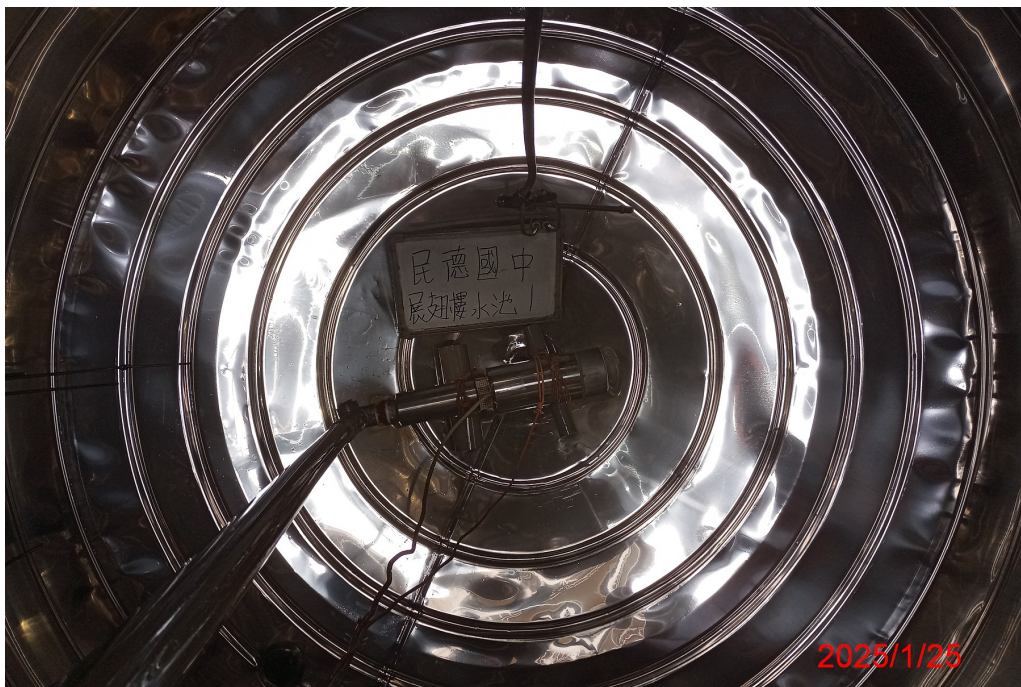
展翅樓水池 1 清洗後
