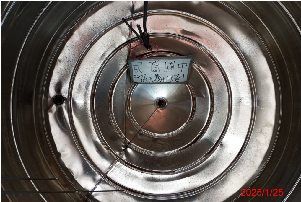
行政大樓水塔 1 清洗前
