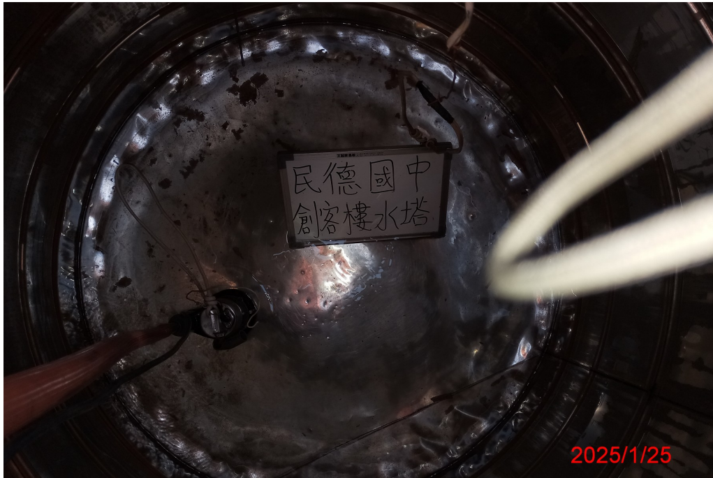
創客樓水塔清洗前
