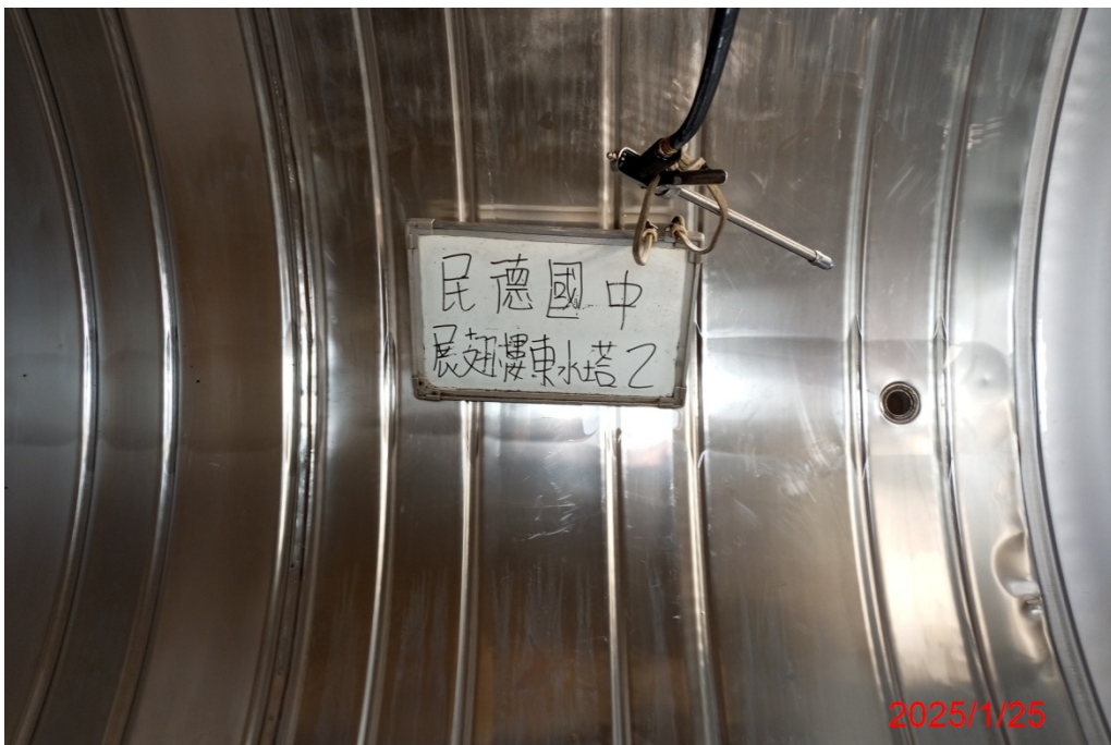
展翅樓東水塔 2 清洗後
