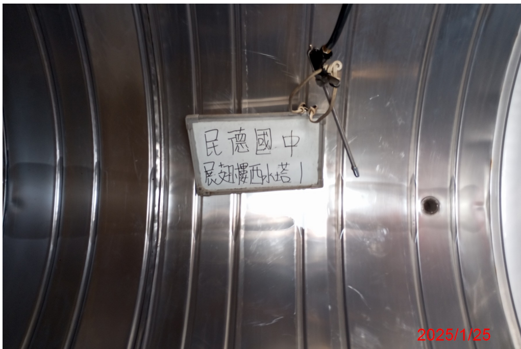
展翅樓西水塔 1 清洗後
