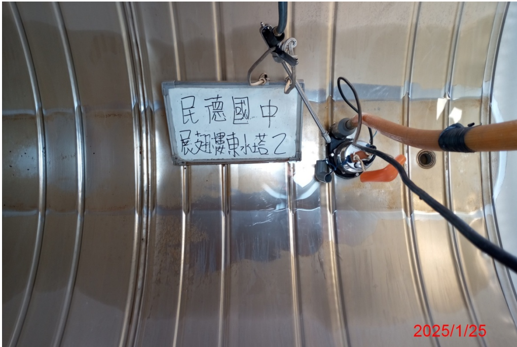
展翅樓東水塔 2 清洗前
