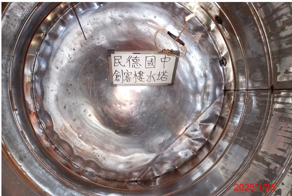
創客樓水塔清洗後
