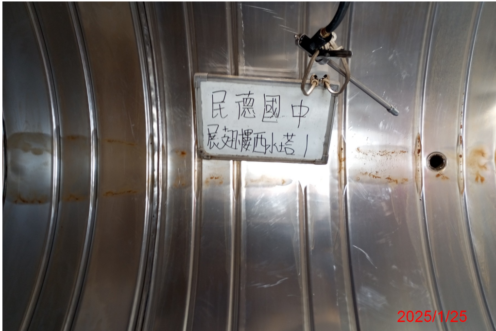
展翅樓西水塔 1 清洗前
