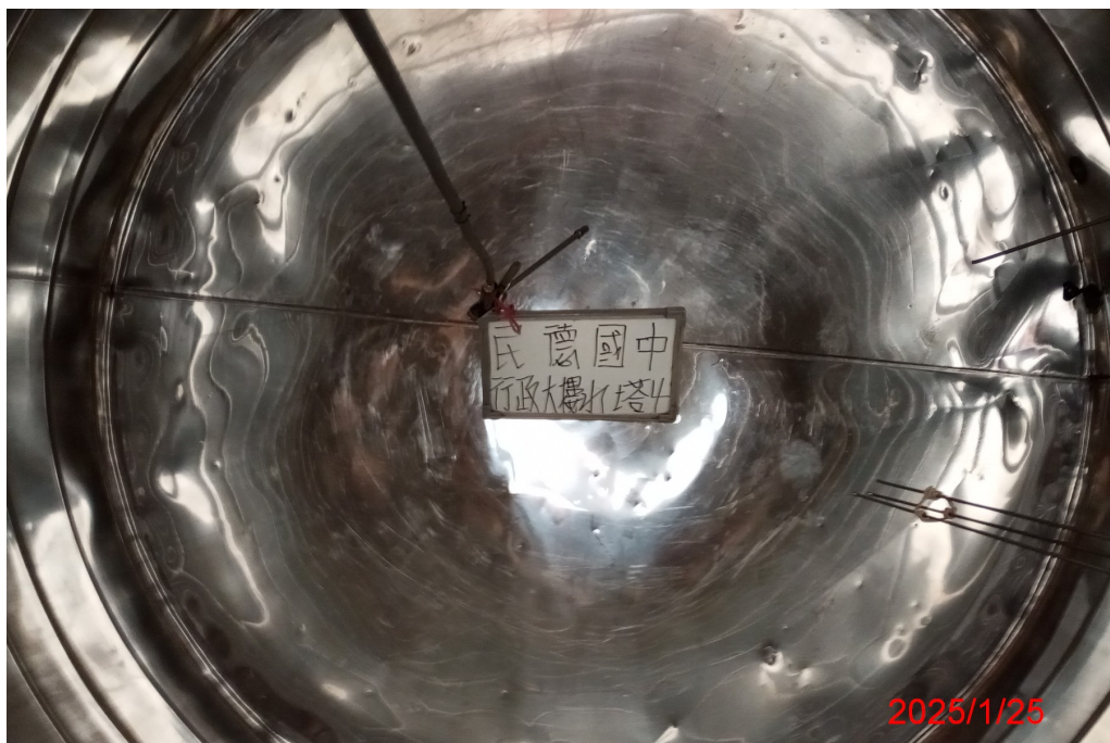
行政大樓水塔 4 清洗後
