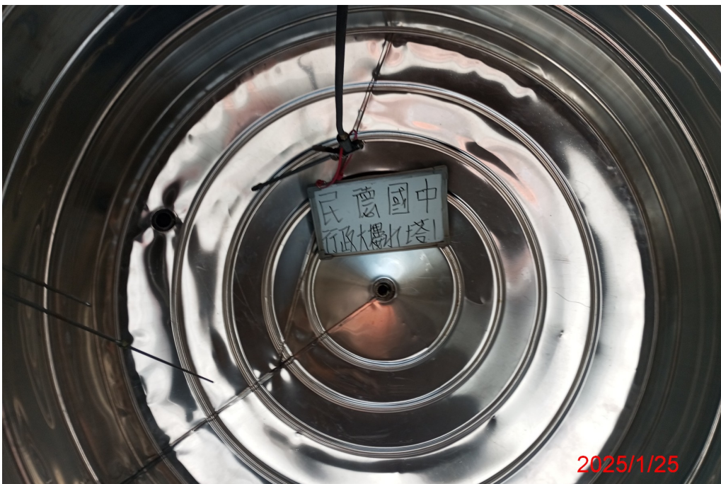
行政大樓水塔 1 清洗後
