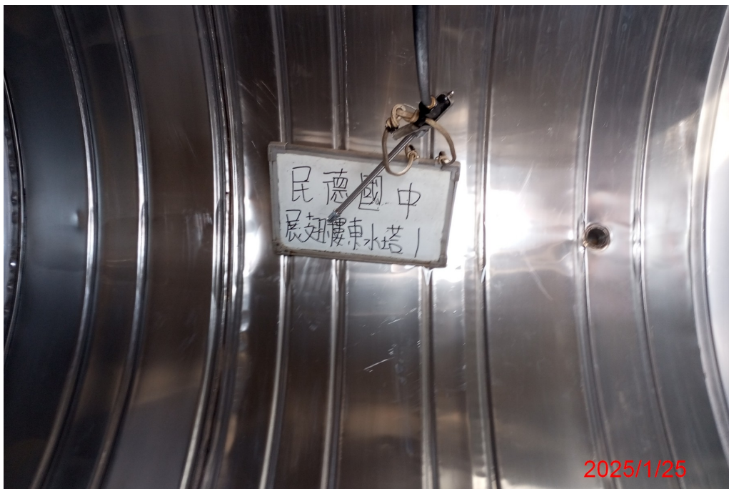
展翅樓東水塔 1 清洗後
