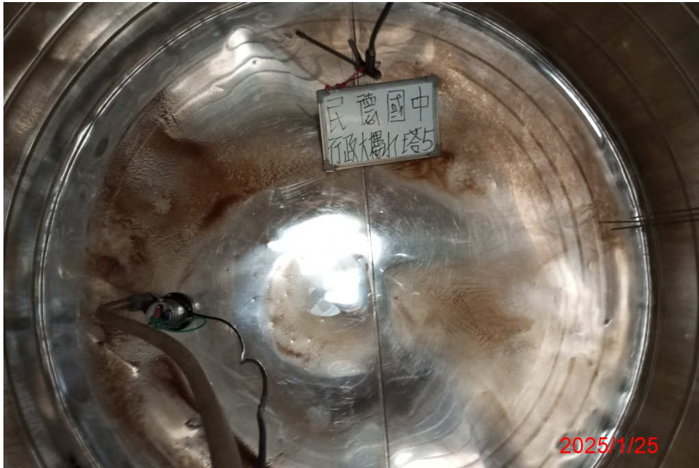
行政大樓水塔 5 清洗前
