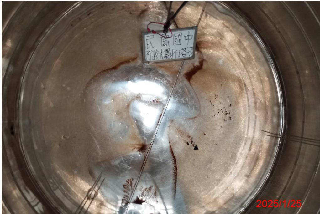
行政大樓水塔 3 清洗前
