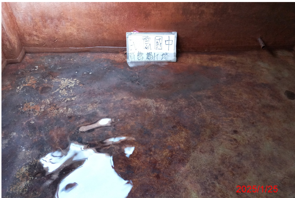
育智樓水塔清洗後
