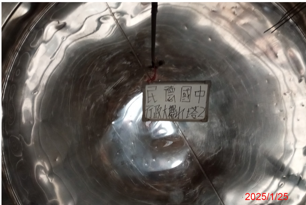
水塔行政大樓水塔 2 清洗後
