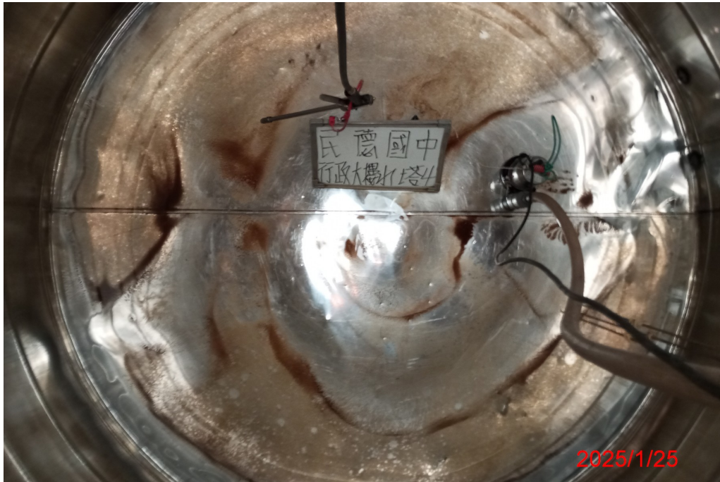
行政大樓水塔 4 清洗前
