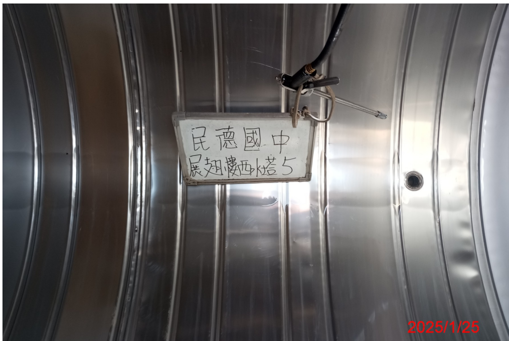
展翅樓西水塔 5 清洗後
