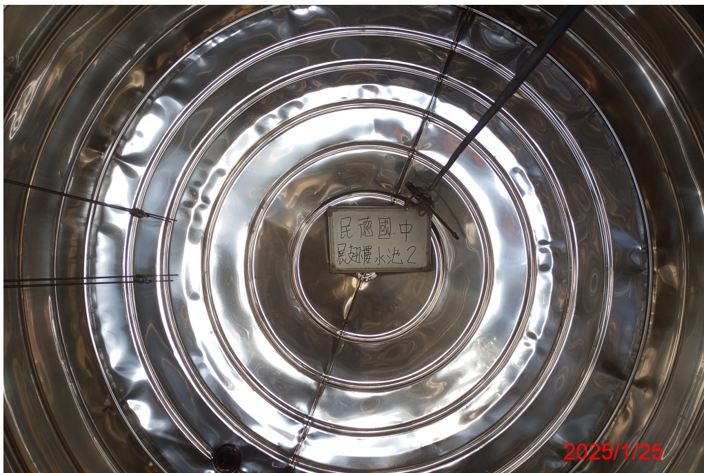
展翅樓水池 2 清洗後
