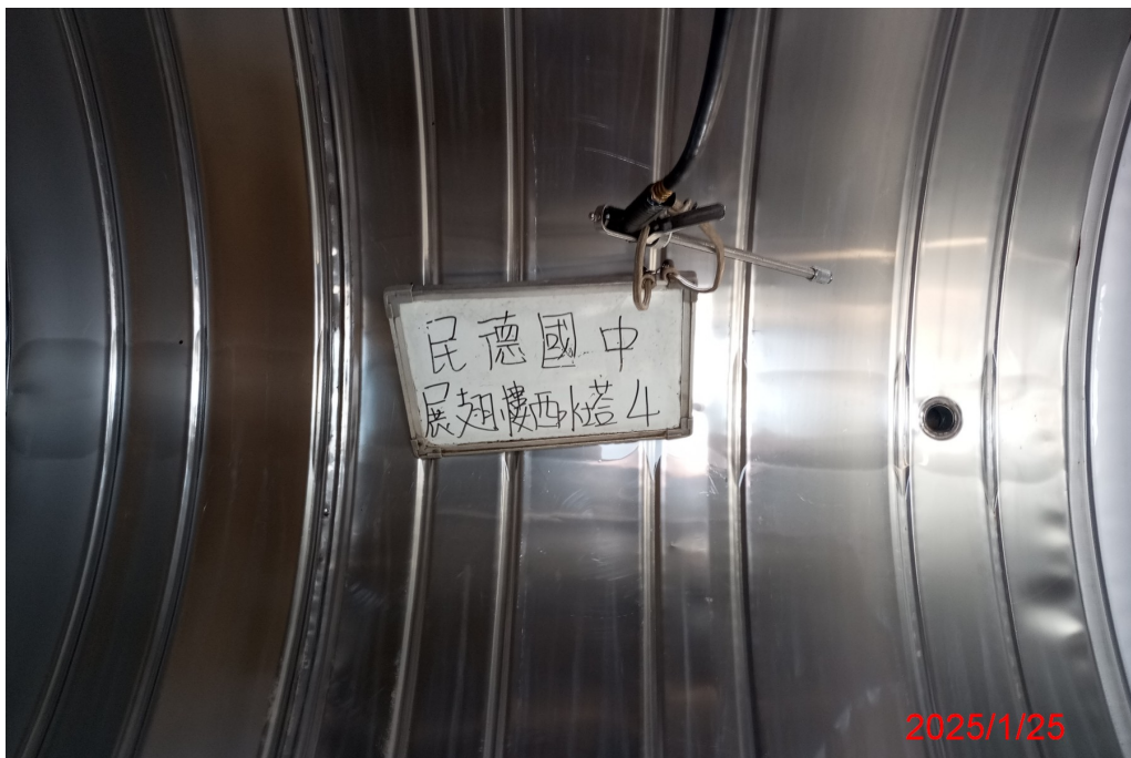
展翅樓西水塔 4 清洗後
