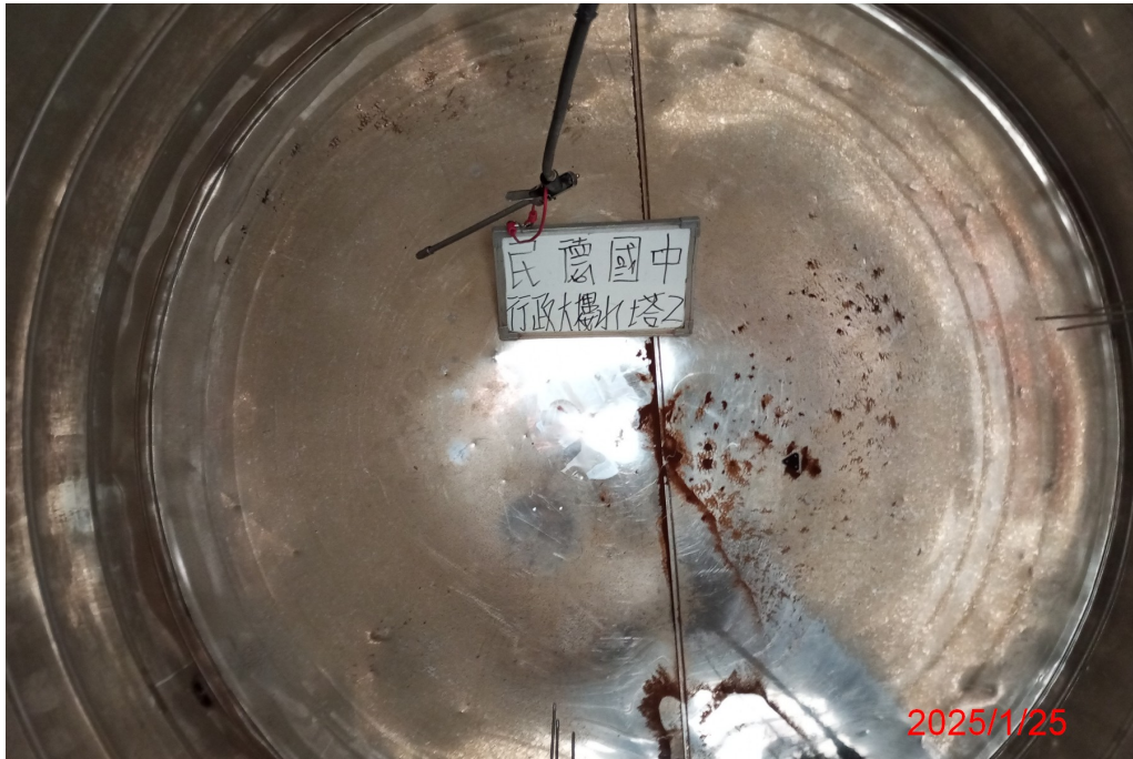
行政大樓水塔 2 清洗前
