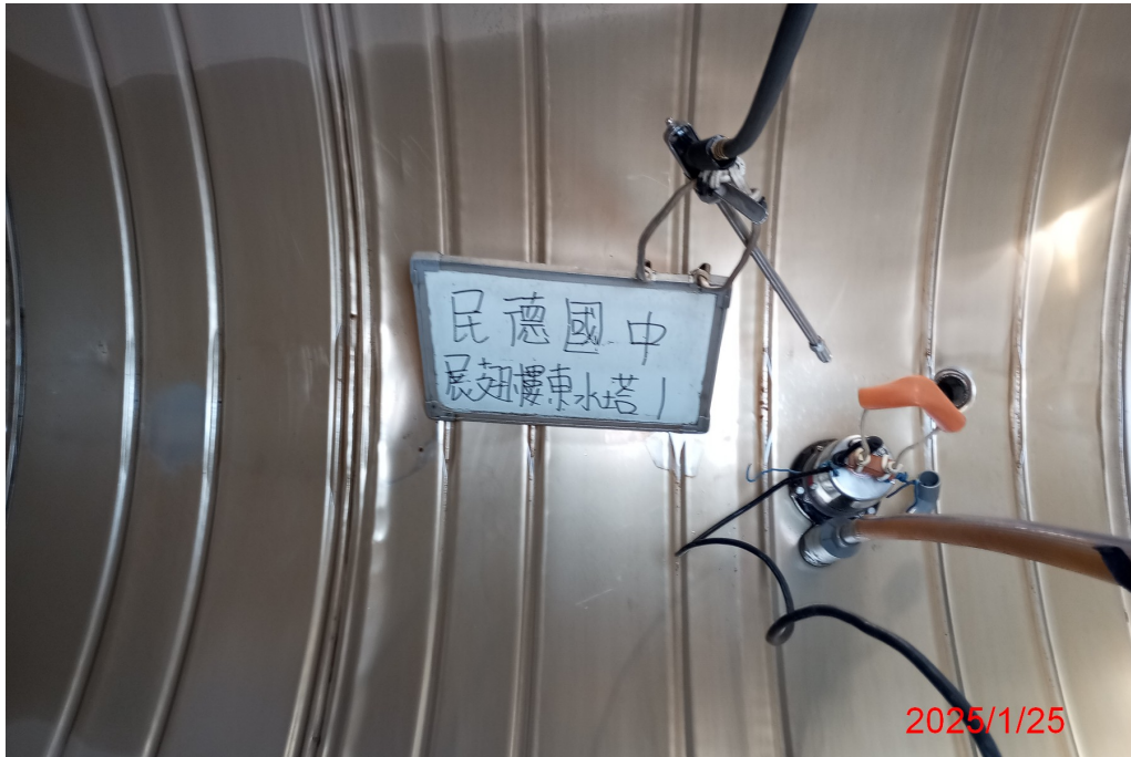
展翅樓東水塔 1 清洗前
