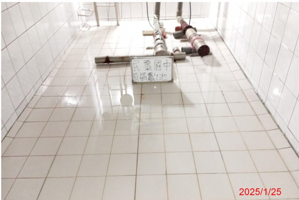
育誠樓水池清洗後
