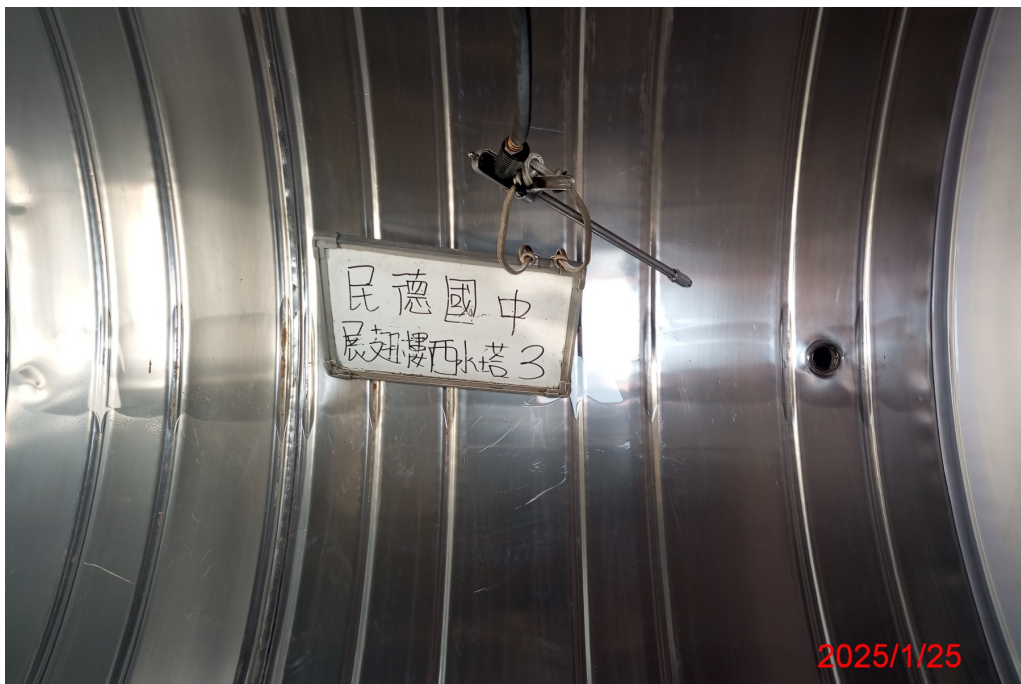
展翅樓西水塔 3 清洗後
