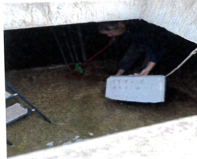
博學樓水塔(西一)清洗中
