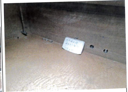
博學樓水塔(西二)清洗後
