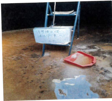
博學樓水塔(東一)清洗中
