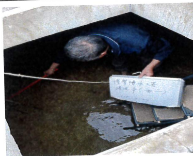
博學樓水塔(西二)清洗中
