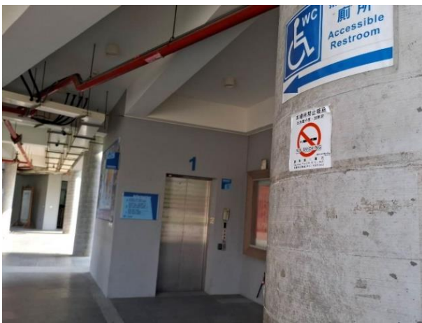
川堂張貼禁菸標誌
