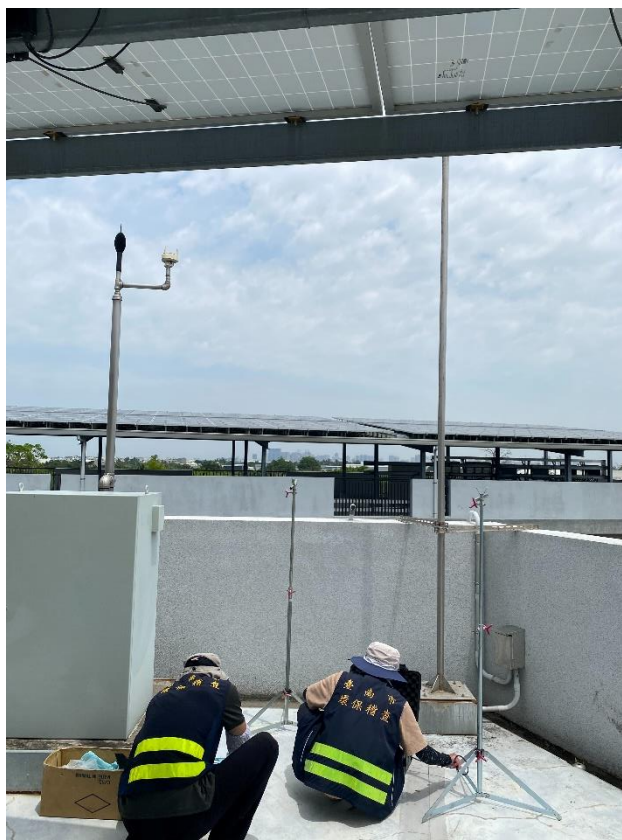
環保局人員正在本校屋頂組裝測量噪音儀器
