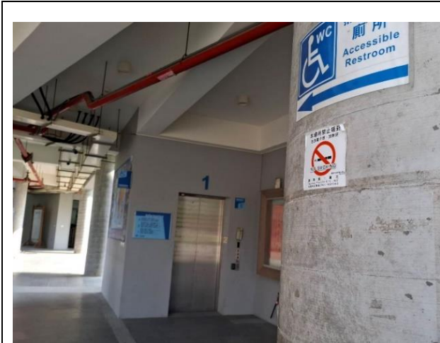
川堂張貼禁菸標誌
