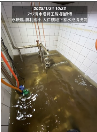
說明:大仁樓蓄水池清洗前
