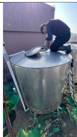
說明:大仁樓頂樓白鐵水塔清洗
