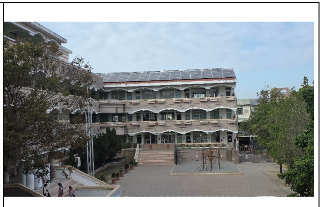
屋頂評估可施作處，設置太陽能板蓄電
