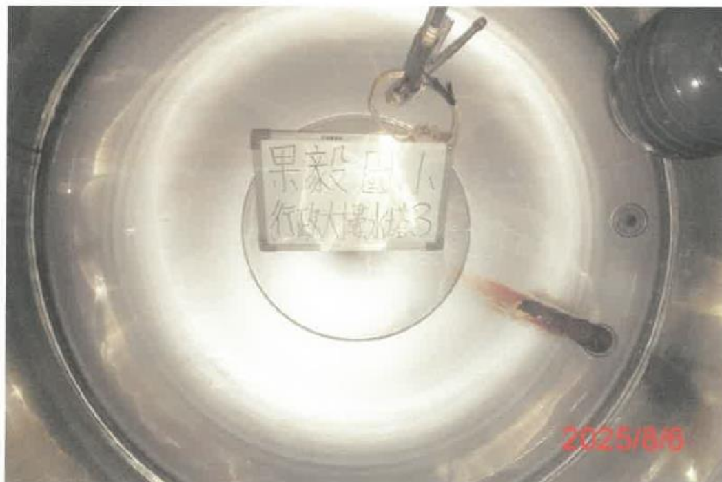
(行政大樓-3)水塔清洗後
