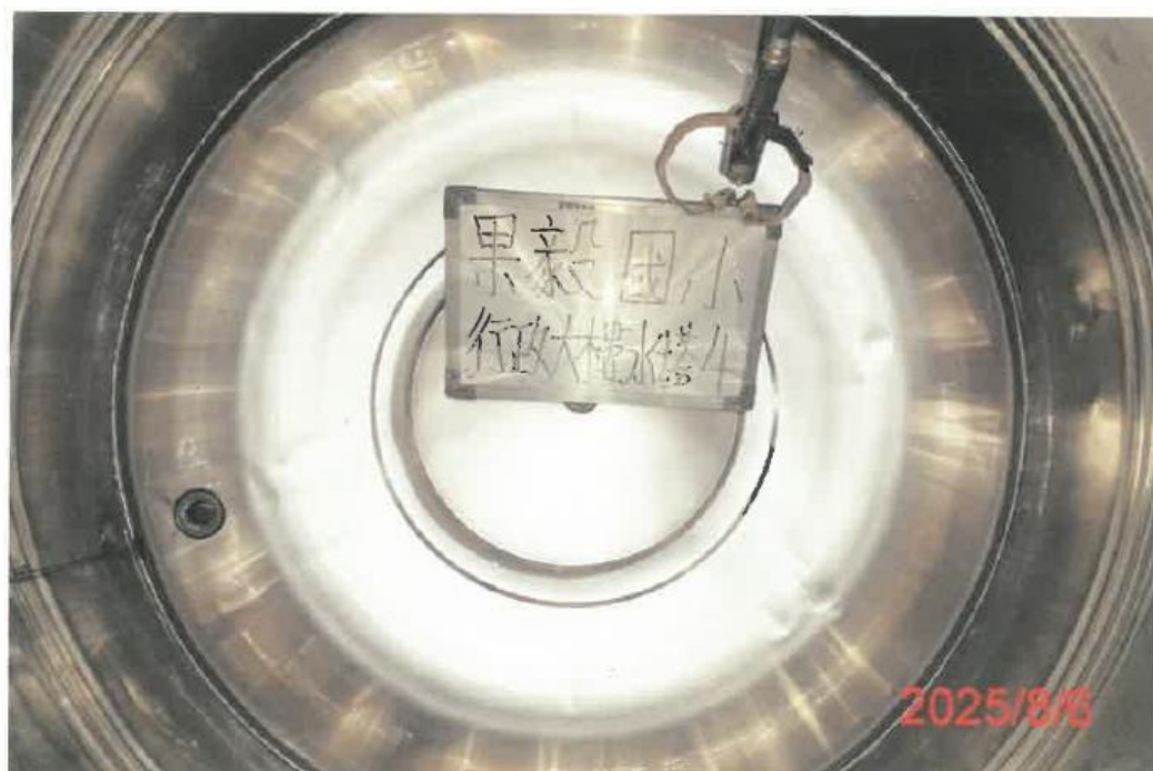
(行政大樓-4)水塔清洗後
