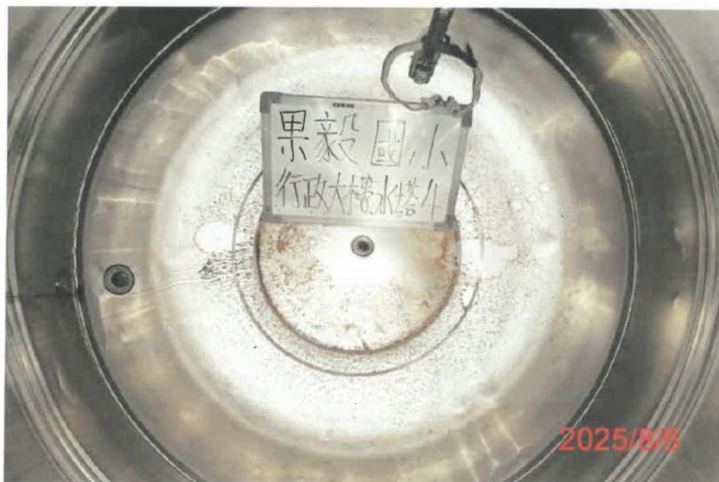
(行政大樓-4)水塔清洗前
