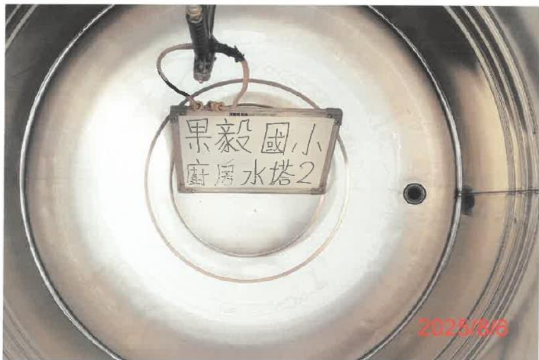
(廚房-2)水塔清洗後
