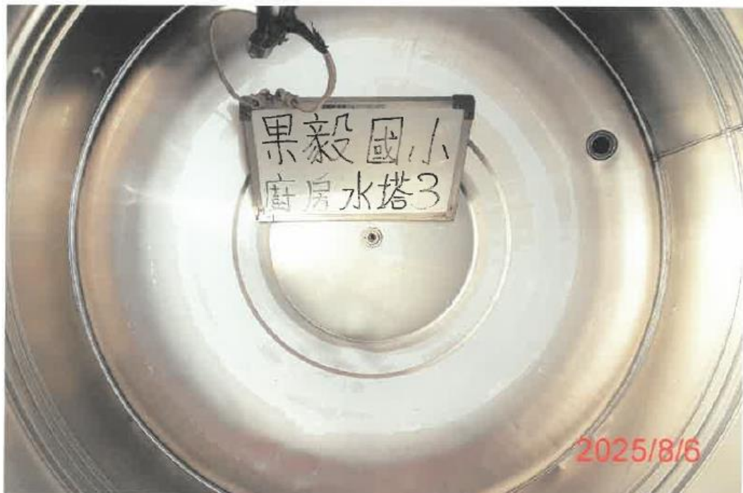
(廚房-3)水塔清洗後
