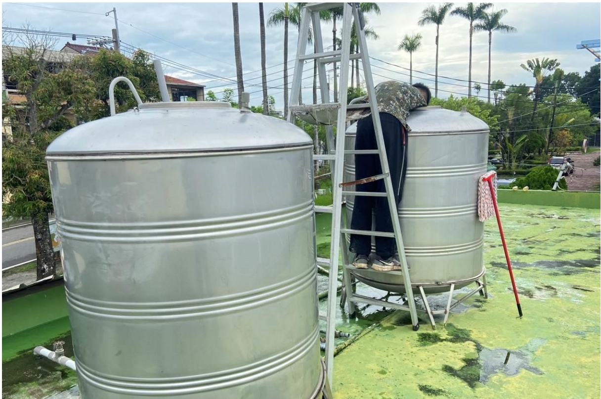
本校水塔定期請專業施工人員完成清洗作業
