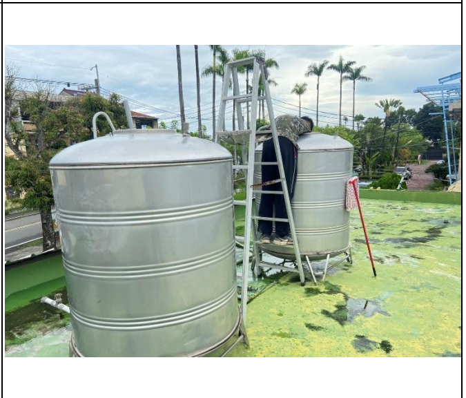
定期完成水塔檢查與清洗
