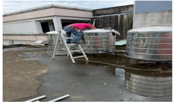
說明：開學期例行雇工清洗水塔。
