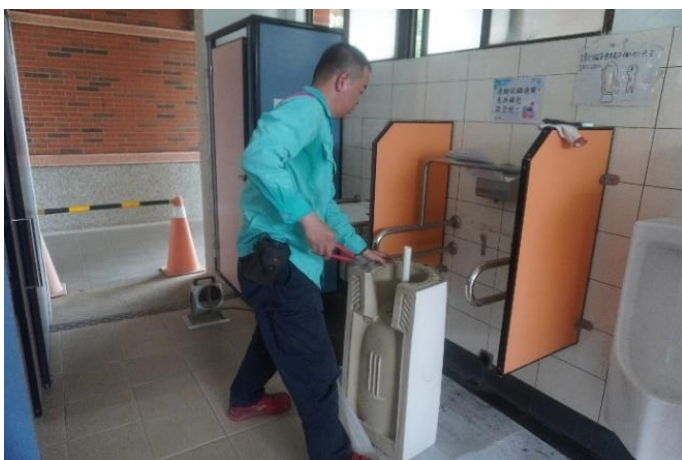
▲小便斗管線破裂維修
