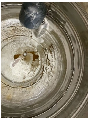
說明：水塔清洗前。
