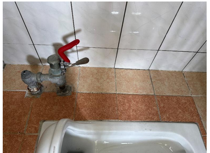
說明：水馬桶使用兩段式節約用水設計
