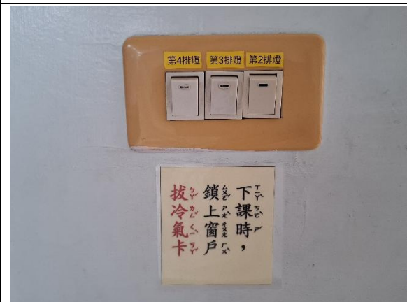
說明:室內空間電路改善設計，已經完成，改善後室內燈具、風扇開啟，可以依所需要之區塊分區開啟。
