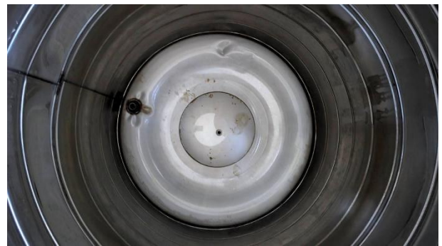
說明：水塔清洗後照片(編號1)
