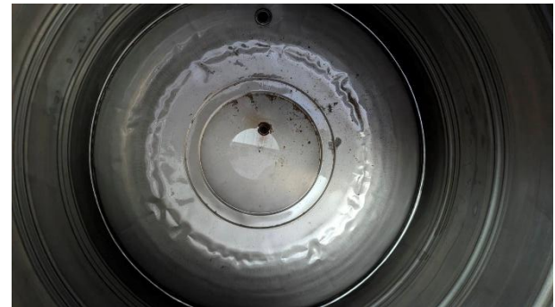
說明：水塔清洗後照片(編號2)
