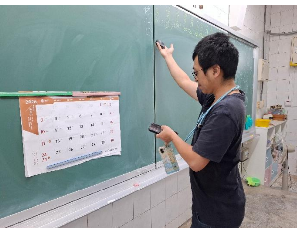
說明:更換燈管後，開燈測光
