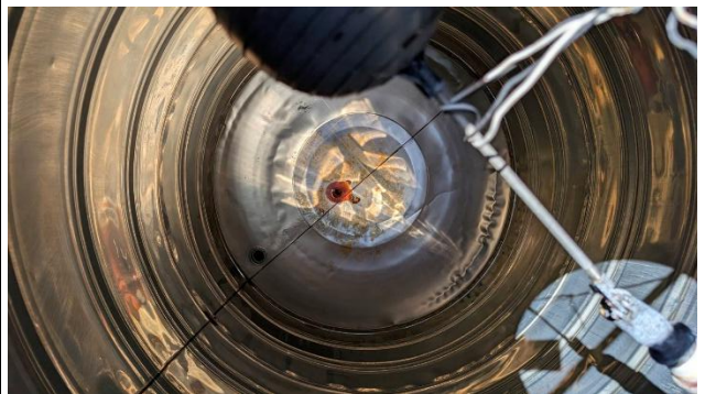
說明：水塔清洗後照片(廚房)
